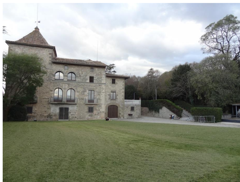
Figura 12. Estat actual de la casa Forta del Despujol
