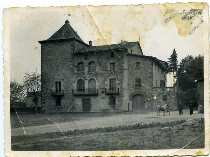
Figura 11. Vista de la façana oest de la casa Forta del Despujol
