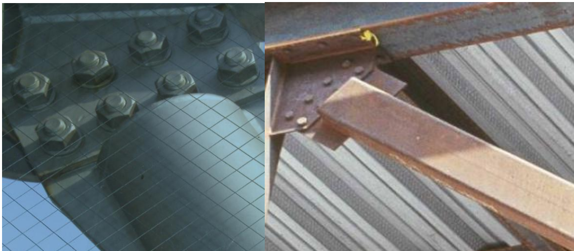
Figura 3.2. Exemples de unions mitjançant ranura. A la esquerra un CHS i a la dreta un RHS.
