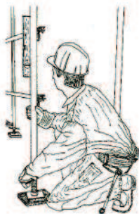
Figura 15. Comprobación de la nivelación vertical
