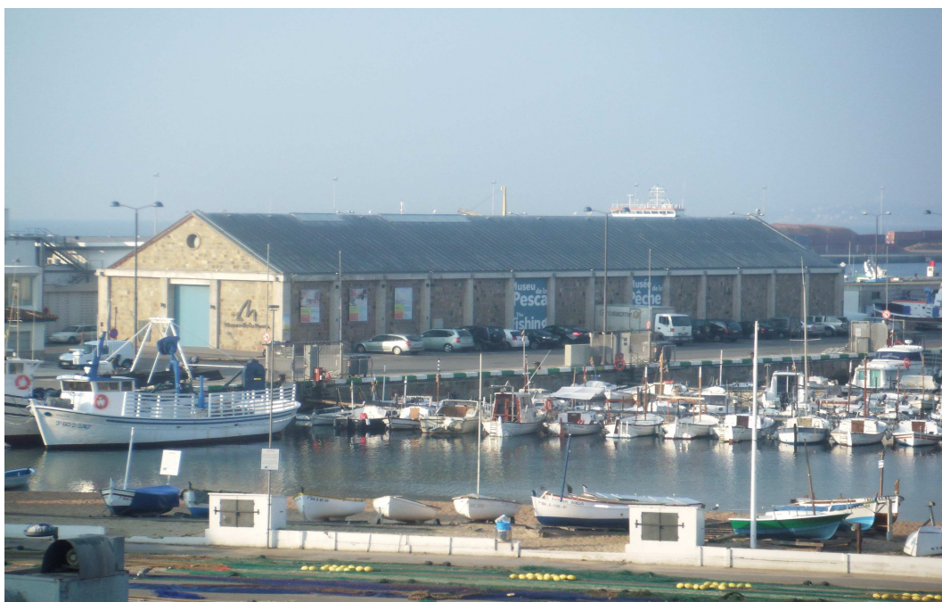
Figura 4.2. L'edifici del Tinglado al port de Palamós que acull el Museu de la Pesca Font: Fotografia de l'autor.
