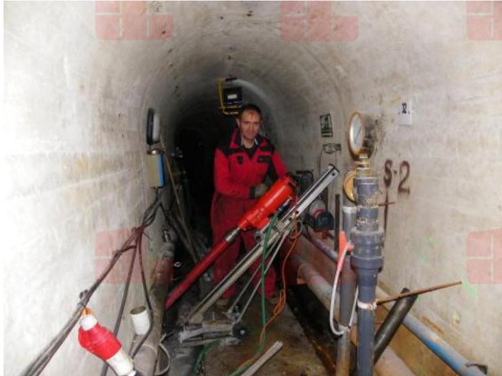
**Figura 2.17.- Extracción de testigo dentro de una galería de presa (ATI, empresa española).**
