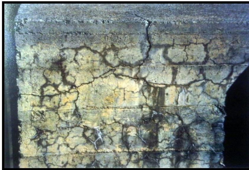
**Figura 2.20.- Fisuración en ramada en paramentos aguas abajo de la presa de Graus, (Aguado et al., 1993).**
