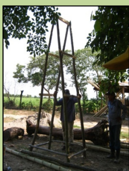
Fig. 54: Construcción de andamios de madera (Jiménez, 2013)
