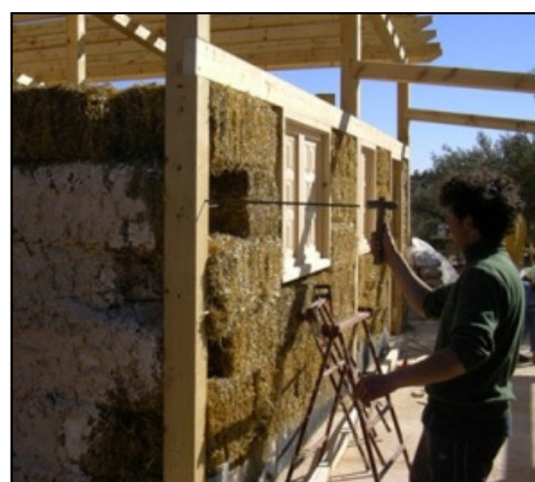
Fig. 17: Refuerzo con armadura (Martín, 2011)
