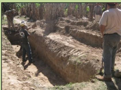
Fig. 49: Excavación de piscina (Jiménez, 2013)
