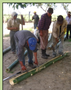
Fig. 48: Preparación de esterilla (Jiménez, 2013)
