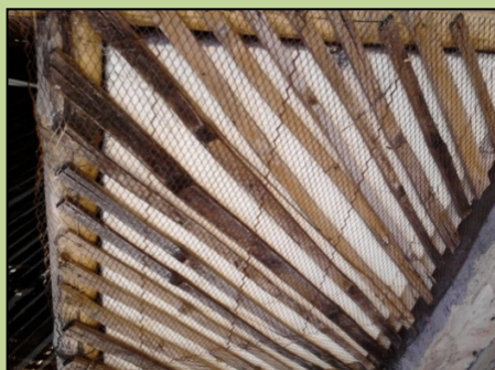
Fig. 64: Tablas de bambú sobre poliestireno (Jiménez, 2013)
