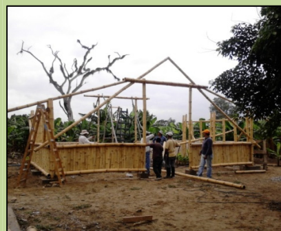
Fig. 60: Colocación de estructura (Jiménez, 2013)
