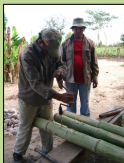
Fig. 58: Perforación con taladro manual (Jiménez, 2013)
