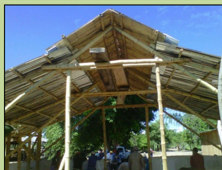
Fig. 71: Cubierta colocada (García, 2014)
