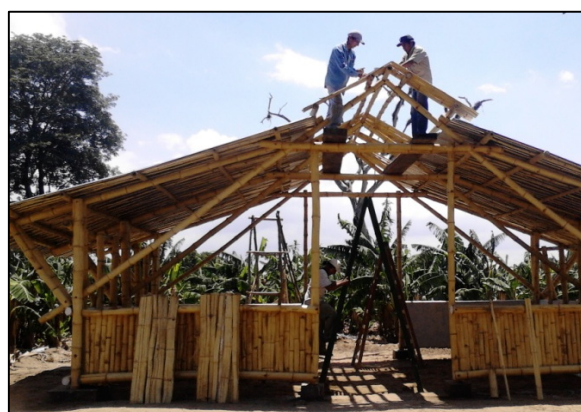
Fig. 41: Colocación de esterilla cubierta (Jiménez, 2013)
