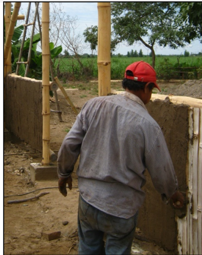
Fig. 37: Revoco de barro, paja y cemento (Jiménez, 2013)
