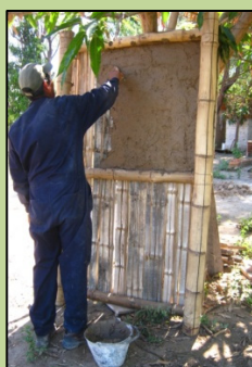
Fig. 61: Muro de esterilla (Jiménez, 2013)
