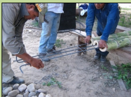
Fig. 56: Medición de armadura y colocación de cercos (Jiménez, 2013)
