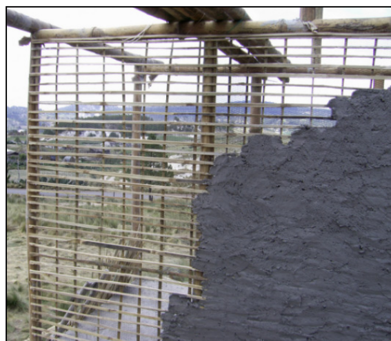
Fig. 33: Muro de bahareque recubierto con cemento (Bambupue 2008)
