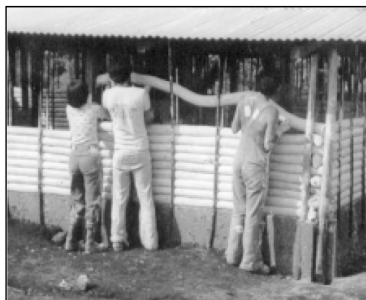
Fig. 16: Construcción con mangueras rellenas de tierra (Minke 2001)
