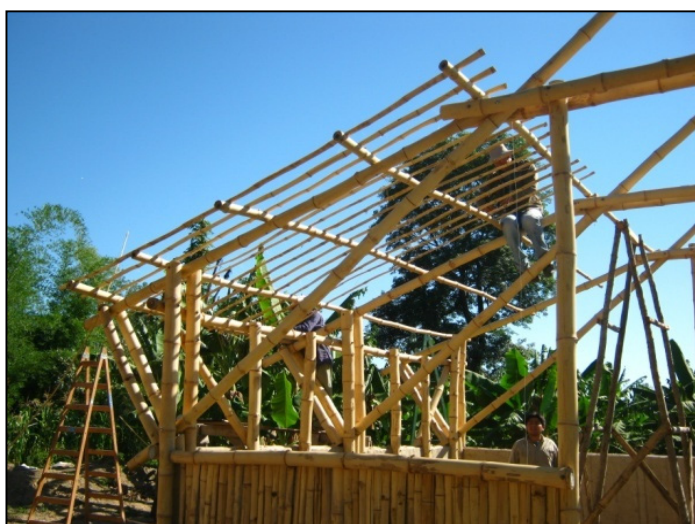
Fig. 39: Entramado de sujeción de la cubierta (Jiménez, 2013)
