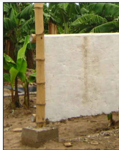
Fig. 36: Aspecto final del cerramiento por la parte interior (Jiménez, 2013)
