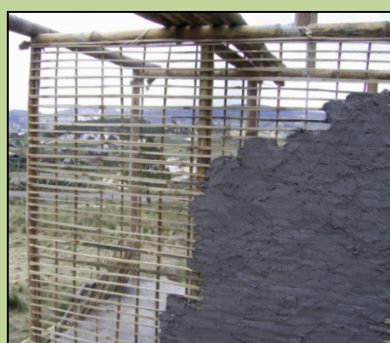
Fig. 66: Muro de bahareque recubierto con cemento (Bambupue 2008)
