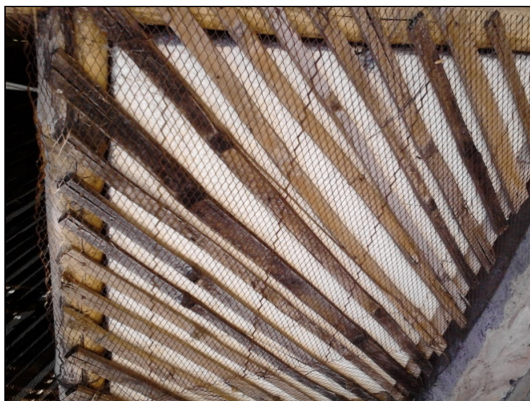
Fig. 32: Cerramiento de aislamiento de poliestireno expandido reforzado con malla y tablas sin recubrimiento de cemento (Jiménez,2013)
