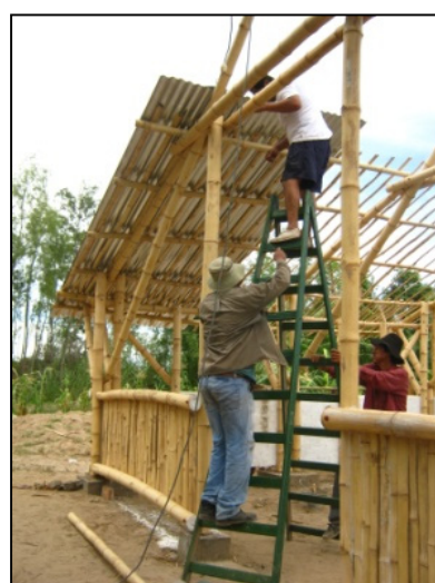
Fig. 40: Cubierta de chapa sin esterilla (Jiménez, 2013)
