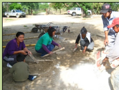
Fig. 62: Preparación de tierra para revestimiento (Jiménez, 2013)
