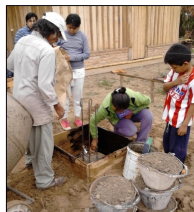
Fig. 24: Engrasado del encofrado (Jiménez, 2013)
