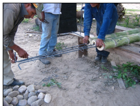
Fig. 23: Separación de armadura de zapatas (Jiménez, 2013)
