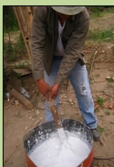
Fig. 68: Apagado de cal (Jiménez, 2013)
