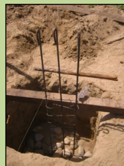
Fig. 57: Colocación de armadura (Jiménez, 2013)
