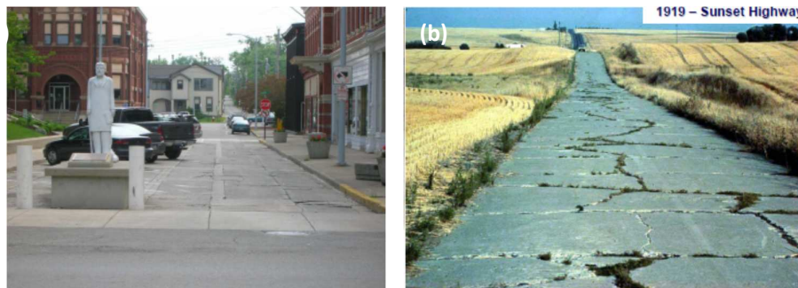
Figura 2.1 (a) Estado actual del pavimento de Bellafontaine en Ohio (b) Pavimento sin juntas (Jaramillo, 2012)
