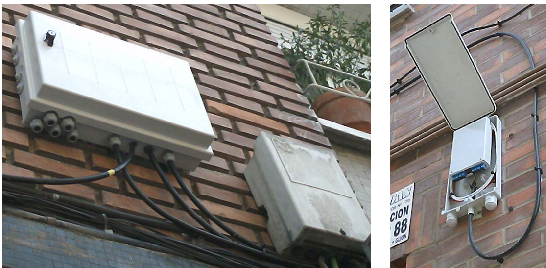
Figura 68. Exemple caixes terminals de 24 i de 8 usuaris
