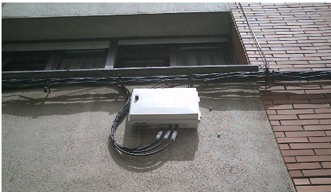
Figura 67. Exemple cablejat per façana
