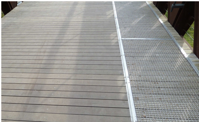
Imatge 5. Exemple de pas per a vianants construït amb fusta.
