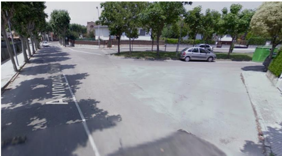
Imatge 11: Encreuament cantonada Avda. Vilamajor sense resoldre, falta de senyalització i ordenació de l'espai.
