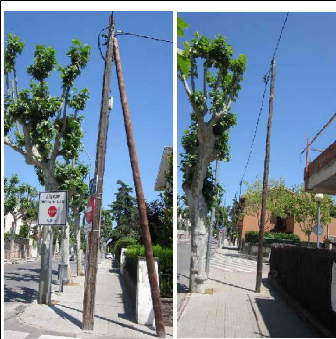
Imatge 8 i 9 : Columnes telecomunicacions i baixa tensió en mig de la vorera que suposen una barrera arquitectònica.
