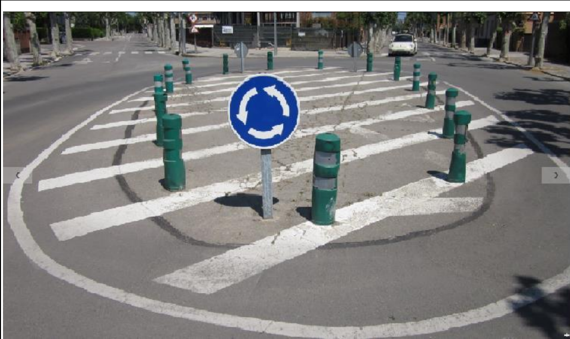
Imatge 2 : Actual estat de la rotonda, on es pot veure que esta constituïda per pilones reflectants i marques horitzontals.
