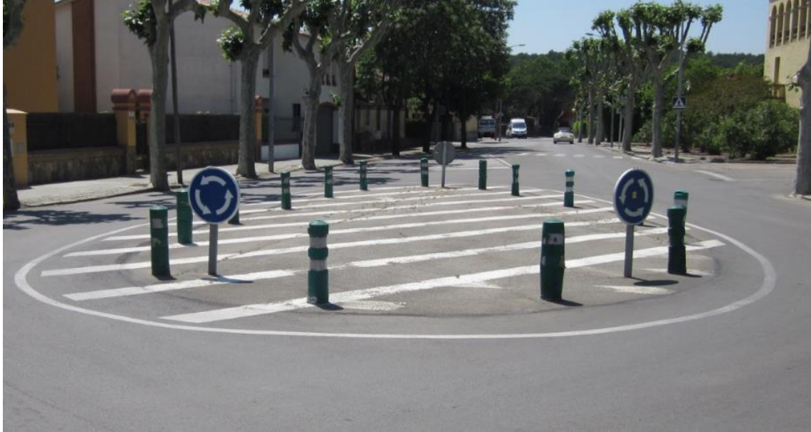
Imatge 4 : Estat de la rotonda des de la cantonada Avda. Vilamajor.
