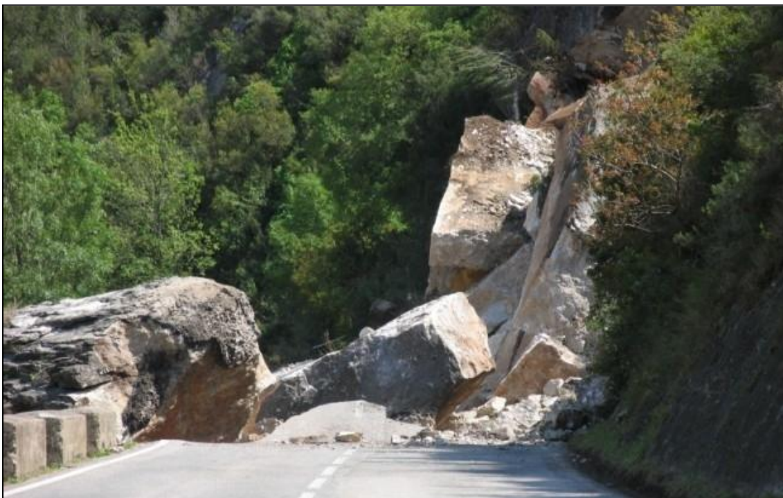
Fig. 1: Exemple de despreniment rocós a la carretera d'accés a la població de Vilaverd (extret de la web de Vilaweb).
