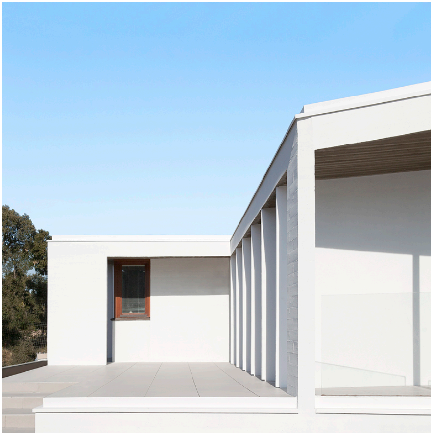
Figura 4.16 Detall façana Sud
