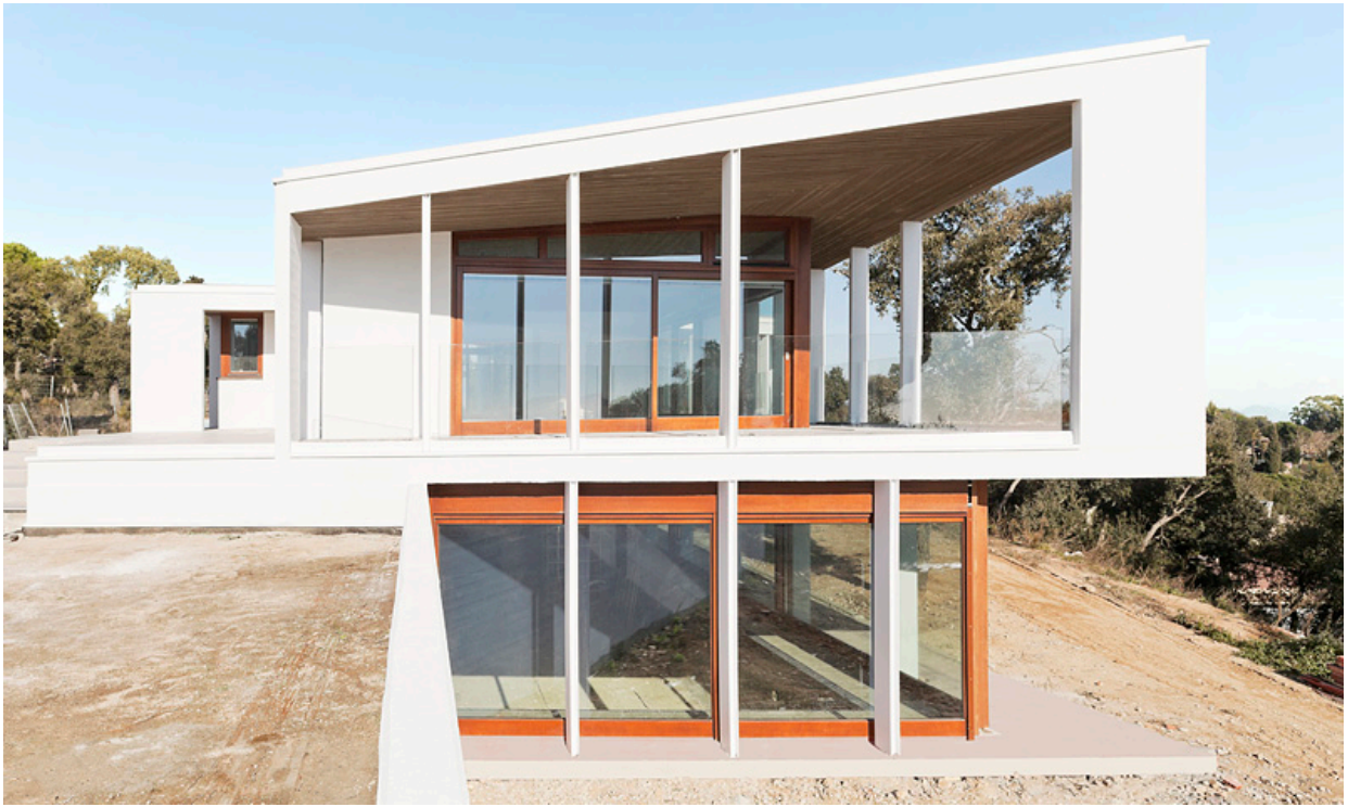
Figura 4.15 Detall façana Sud
