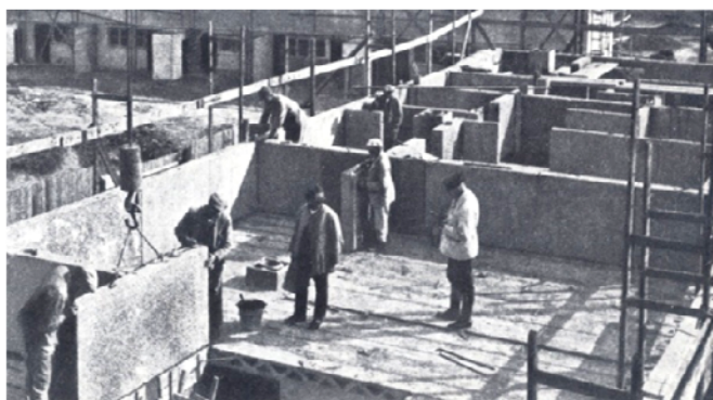
Construcción con elementos prefabricados, paneles moldeados. Stuttgart 1927
