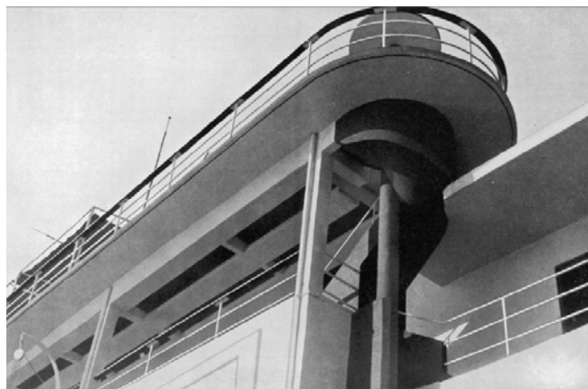
Detalle escalera de caracol
