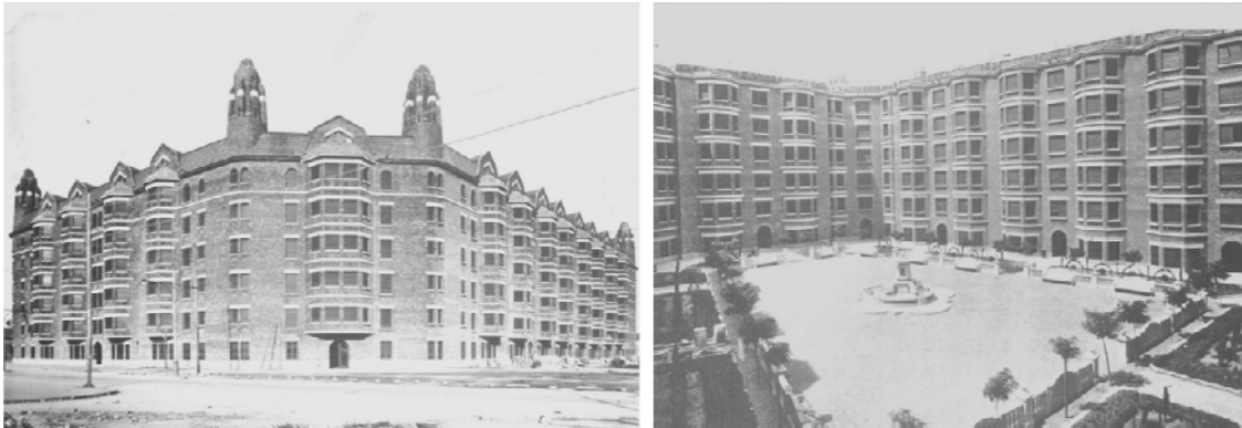
Vista general exterior y del patio interior tras su ejecución
