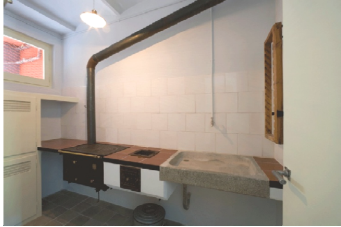
Cocina de la Casa Bloc: cocina económica a carbón, fregadero de piedra y armario despensa.
