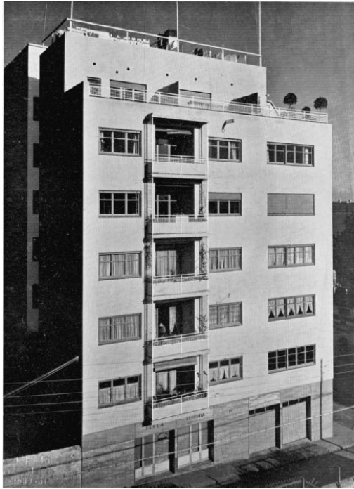
Fachada C/Ríos Rosas
