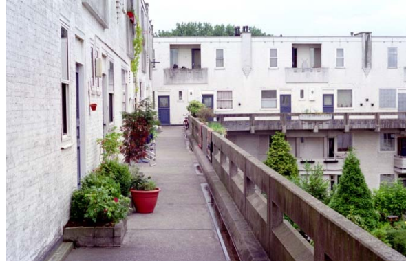
Spangen: galería de hormigón
