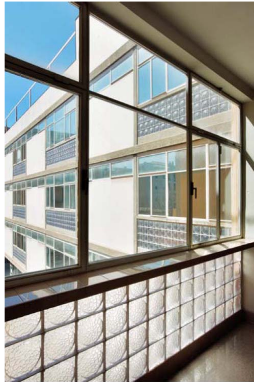
Vista interior desde el corredor de distribución
