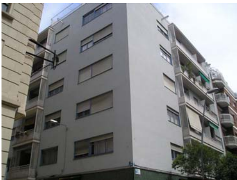
Vista actual del edificio
