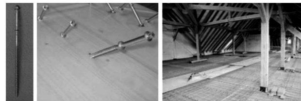
Los conectores madera / hormigón
