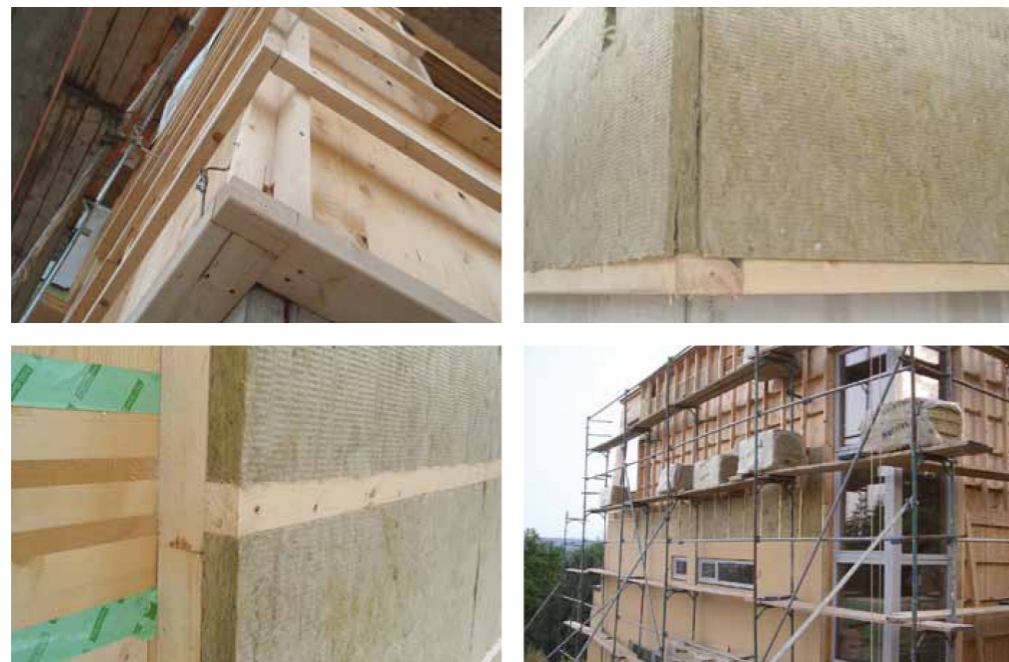
Detalle tipo de fachada (Stora enso)
