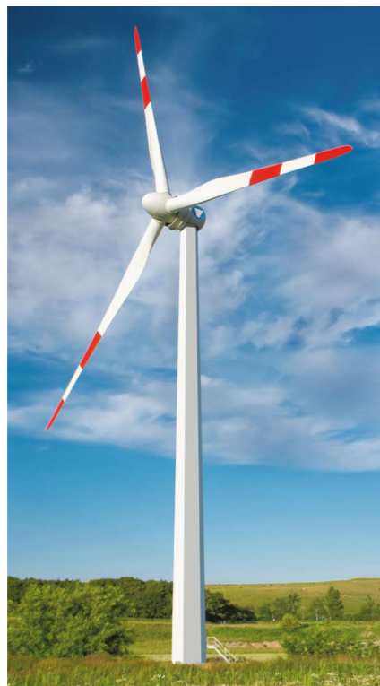
Timber Tower. Molino de viento en TCL, con alturas de 100 a 150m en lugar de los 50 o 75 usuales.
