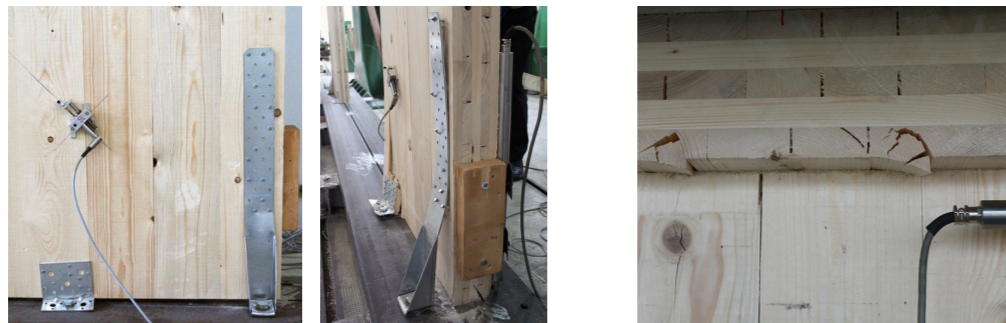
Daños en pletinas en tests y afectación por cortante de un tablero
