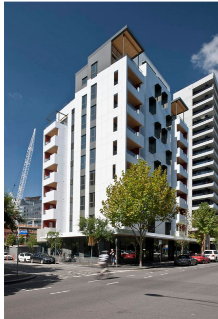
“Lend Lease, empresa inmobiliaria australiana, ha desarrollado lo que ellos llaman “el edificio de viviendas de madera más alto del mundo”, en el puerto de Victoria, en Melbourne, Australia... ...El edificio Forté Apartments se compone de 10 pisos, con 23 departamentos residenciales... Forté es el primer edificio de departamentos de gran altura en Australia que se construye usando madera laminada CLT...” (2013)
