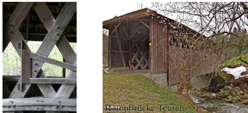
Puente de Rotenbrücke, 1862, IthielTown
