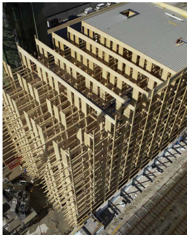
Almacén de logística de Salinen Austria. 2.420 m 2 - 25m altura - 13 plantas, producido por MM Kaufmann Holz, arquitectos: Dr. Shebl and Partners.
