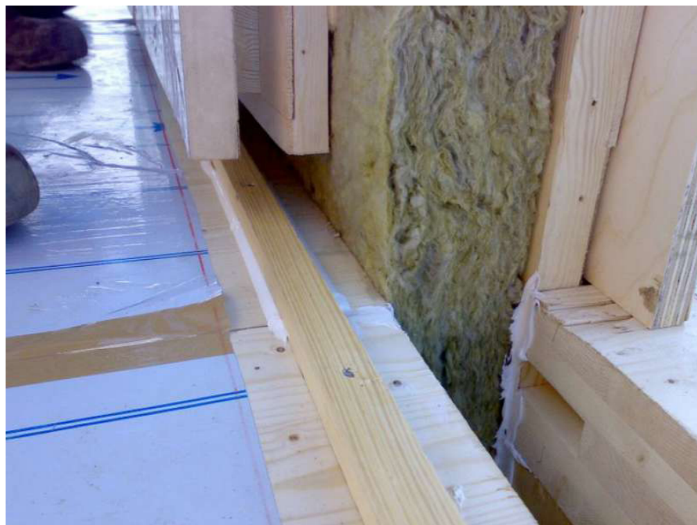
Construcción en el detalle.
