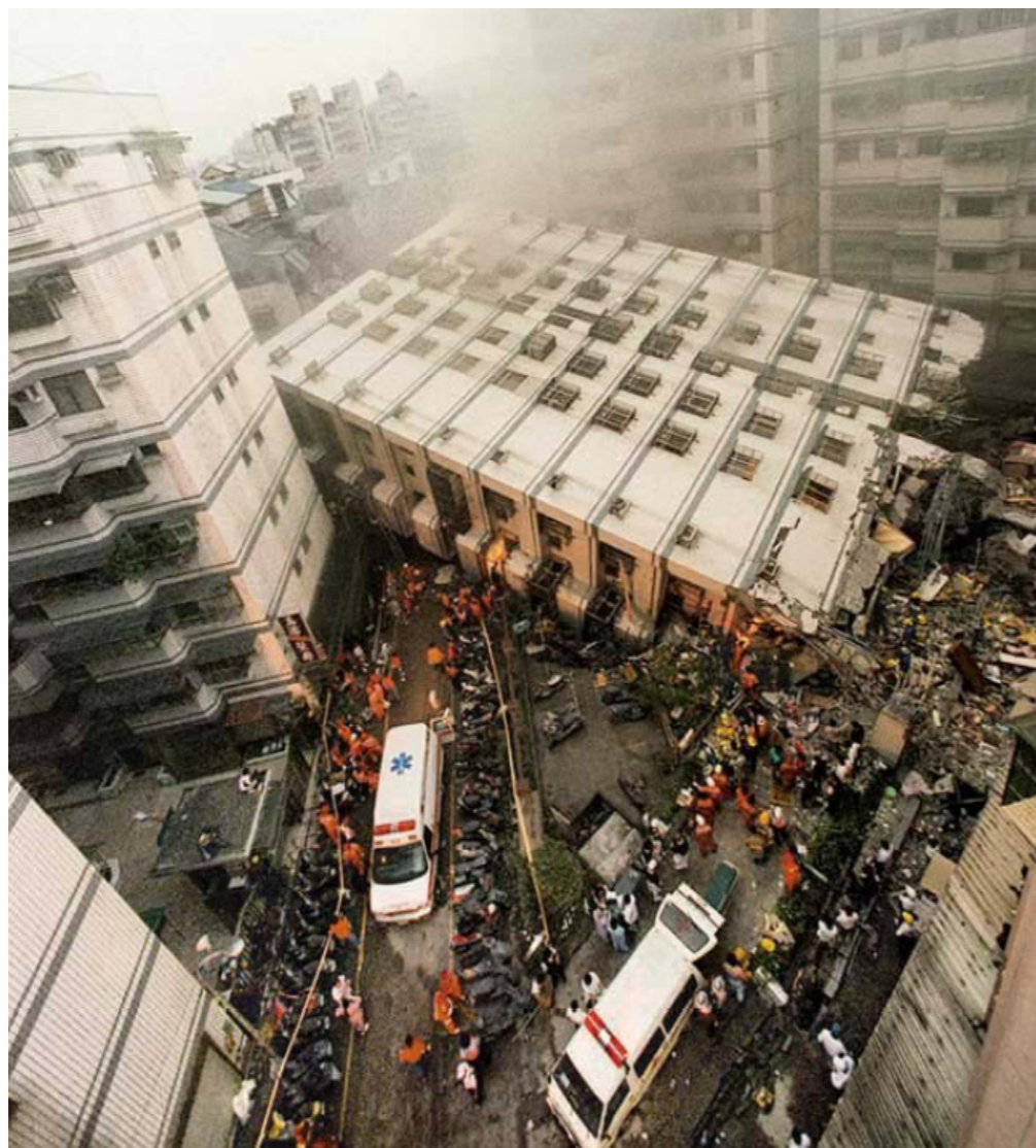
Falla por planta débil.
