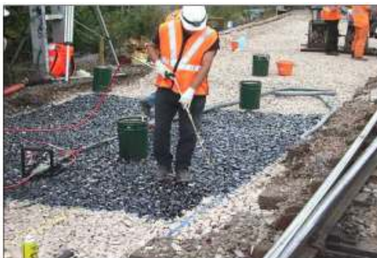
Figura 5.1 Riego de Poliuretano sobre capa de balasto Xitrackr
