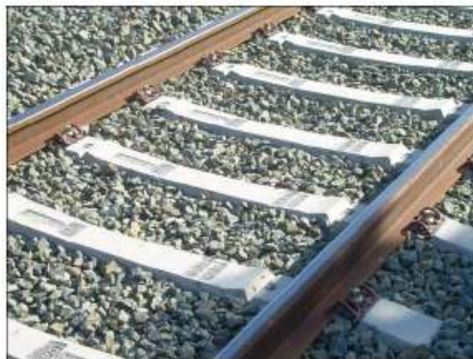
Figura 2.5 Traviesas sobre balasto.
