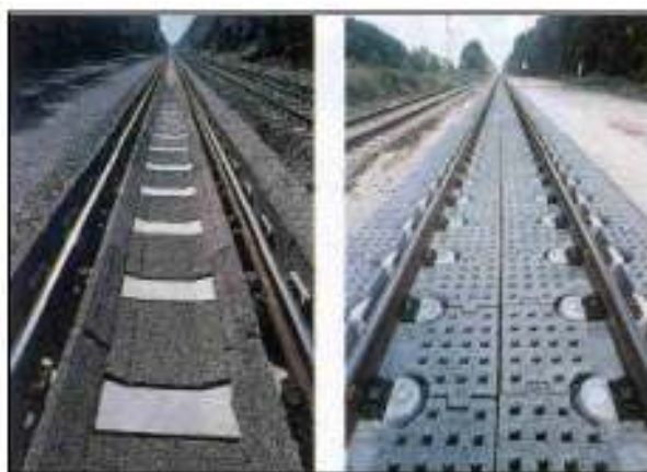
Figura 3.4 Reducción sonora para vías de alta velocidad
