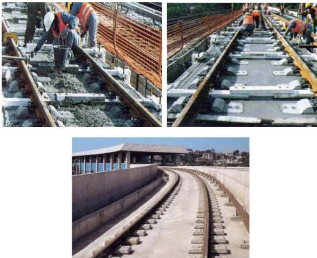
Figura3.1 Imágenes del proceso constructivo y vista final de acabado de vía en placa
