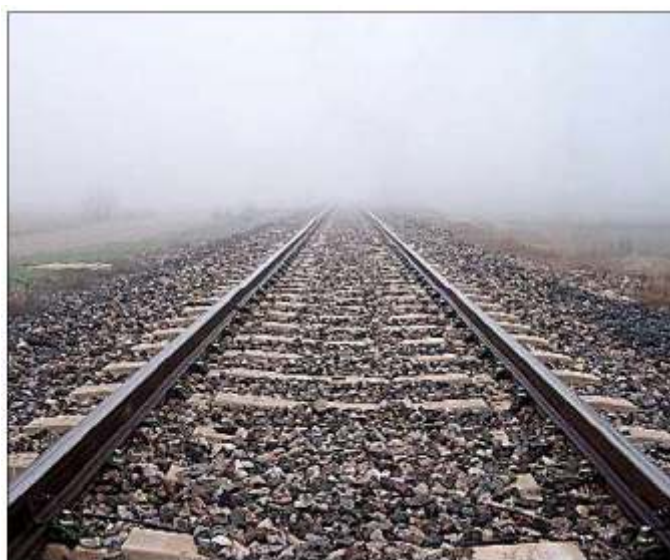
Figura 2.6 Vía en balasto
