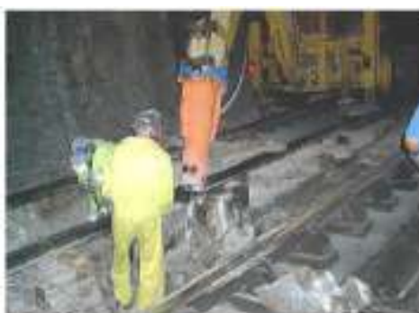
Figura 3.2 Picado de la losa de hormigón hasta la presolera
