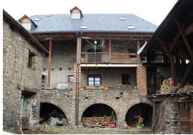
Interior del pati, mirant edifici A, façana Sud
