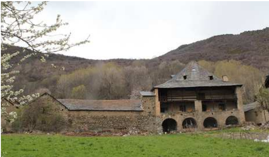
Façana Est, imatge de tot el conjunt de la vivenda, eres i paller
