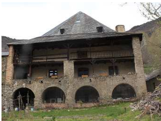
Vista façana Est
