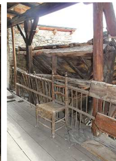
Imatge de l'estat de la terrassa
