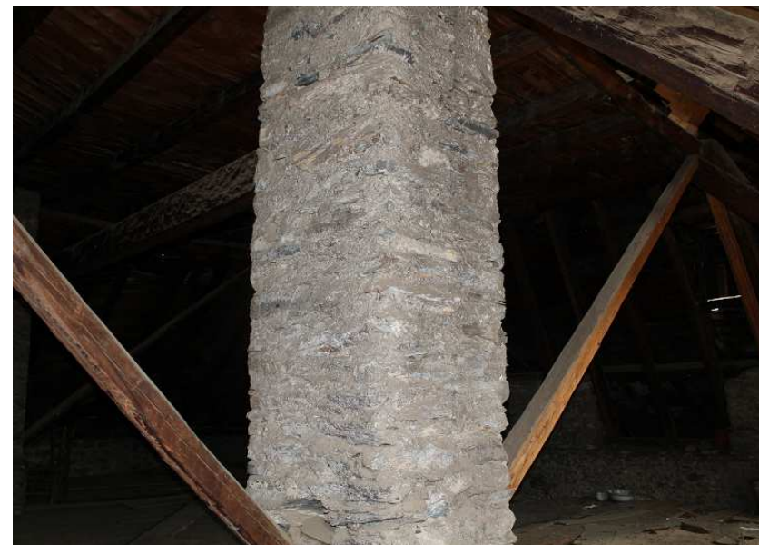
Detall d'un dels pilars
