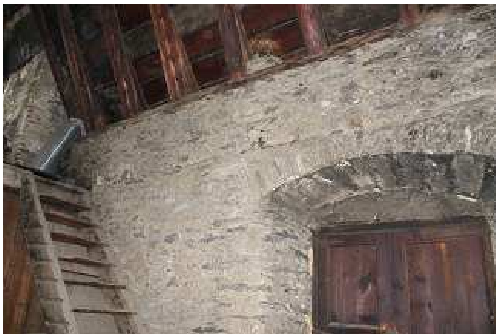
Paret interior, accés actual a la Planta segona
