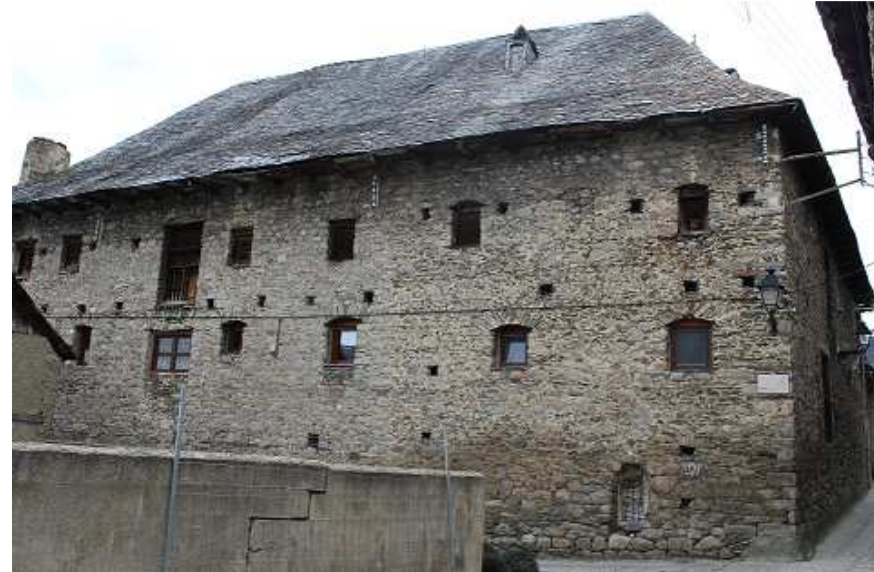
Vista façana Nord
