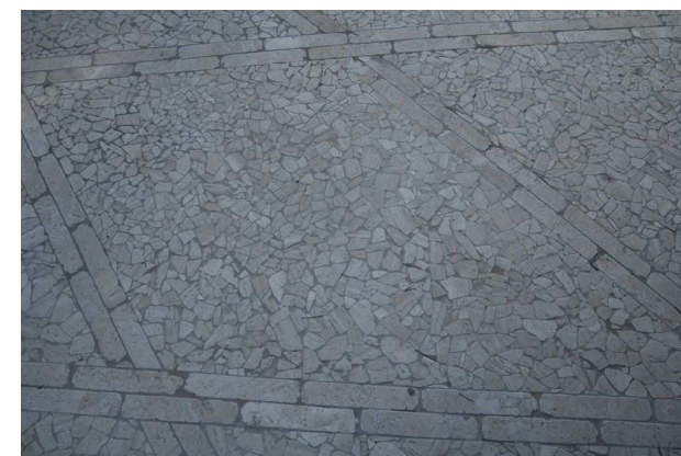
Adoquí de Calatorao com a paviment per al pati
