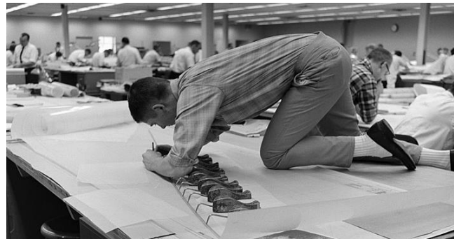
[fig.25] Trazado de una Spline en el Boeing Engineering Department antes de la definición matemática de De Casteljau (para Citroën) y de Pierre Bézier (para Renault) en 1959.
