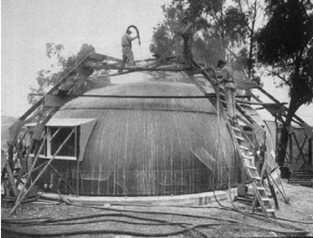
[fig.81] Estructura neumática usada en las Airform House. Los Angeles, EEUU. Wallace Neff, 1940's
