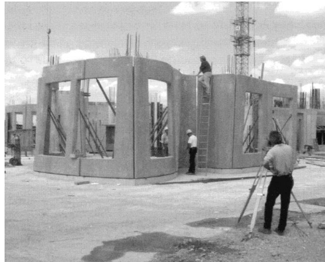
[fig.74,75] Ensamblaje en obra de los paneles de hormigón para el Neuer Zollhof.
