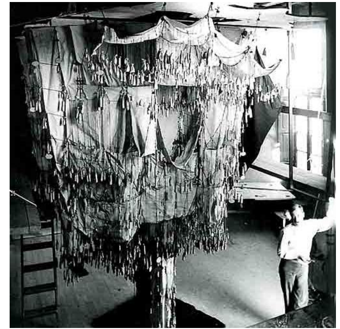
[fig.07] Maqueta Funicular para la Iglesia de la Colonia Güell. Barcelona. Antoni Gaudí; Joan Bertrán, 1898-1908.
