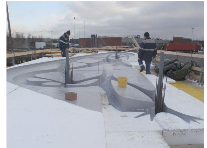
[fig.80] Encofrado para el Unikabeton Prototype.
