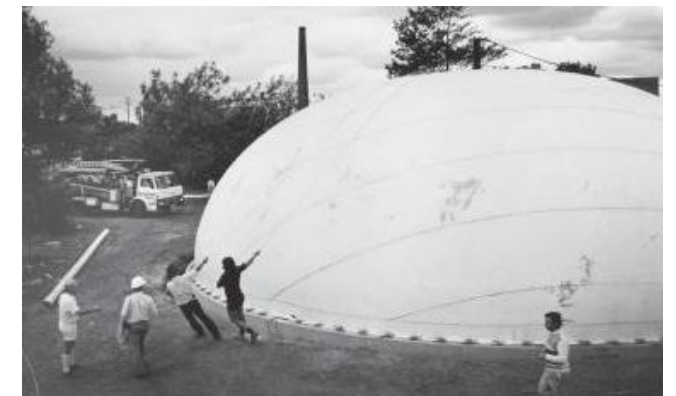
[fig.83,84] Preparación y levantamiento de una Binishell. Dante N. Bini, 1960's
