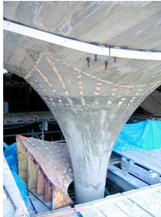
[fig.66] Encofrado de pilares para el Crematorio Meiso no Mori.
