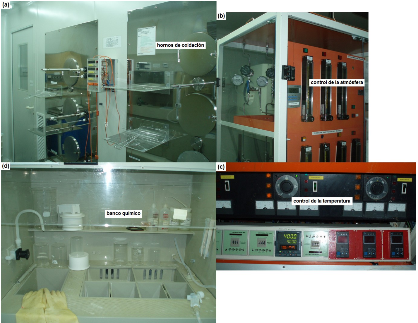
Figura A.10. (a) Sala de hornos donde se realizan los procesos de alta temperatura como oxidación, difusión y recocido, siendo cada horno dedicado a un determinado proceso. Los hornos consisten en un tubo de cuarzo donde se realiza el proceso, y sus sistemas de control de la atmósfera y la temperatura. (b) En el horno de oxidación podemos controlar si la atmósfera será de oxígeno seco, vapores de agua o de inerte nitrógeno. (c) También podemos controlar la temperatura en tres zonas del horno: en la zona cercana a la apertura del tubo de cuarzo, media e interior. Creando así un gradiente de temperatura determinado. (d) Tras la oxidación debemos eliminar el óxido de las muestras mediante un ataque químico con HF, que se realiza en el banco químico mostrado especialmente preparado para el uso de agentes químicos peligrosos.
