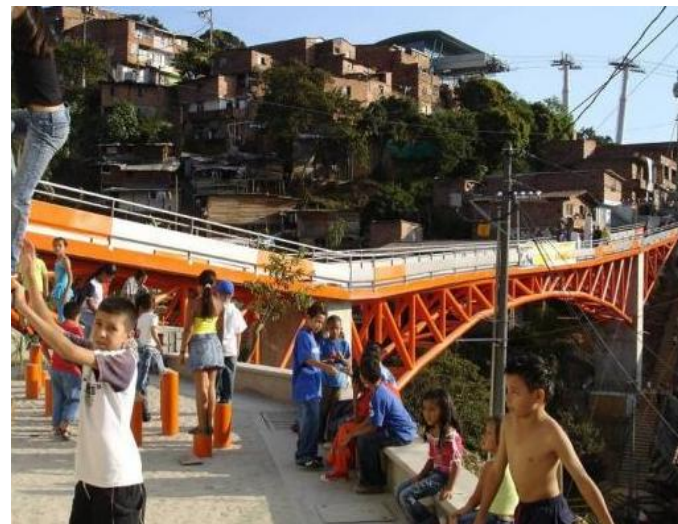
Figura 12: Puente peatonal Andalucía-La Francia, PUI Nororiental. Año 2008. Fuente: Archivo EDU
