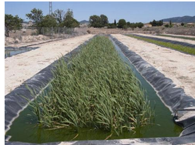
Figura 9: Humedal artificial. Fuente: http://www.aguamarket.com , 19 de junio de 2012.
