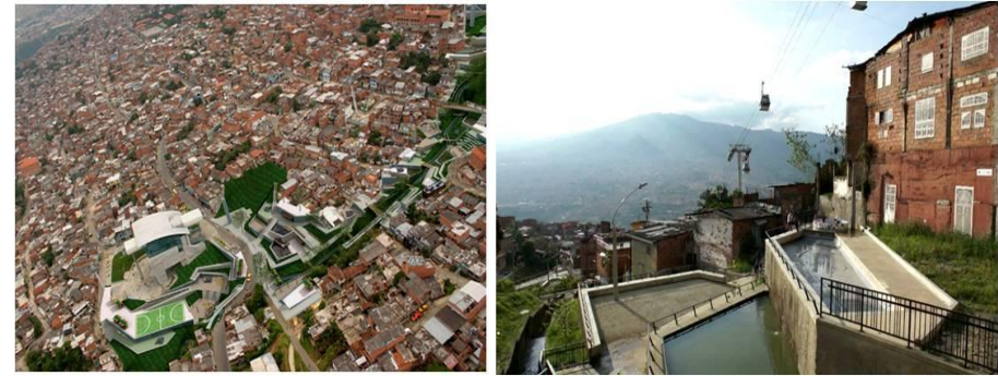
Figura 39: Fase de diseño y construcción del parque Lineal de la Herrera. Año 2010 Fuente: Archivo EDU
