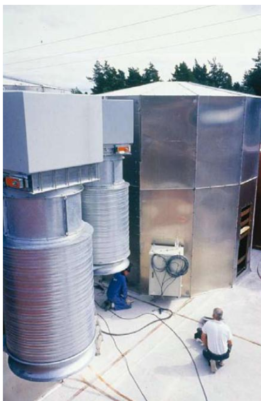
Figura 1.4: Inductància d'acoblament. Cortesia d'ABB
