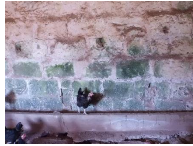
Fig.103. Mur de contenció a edifici 2
