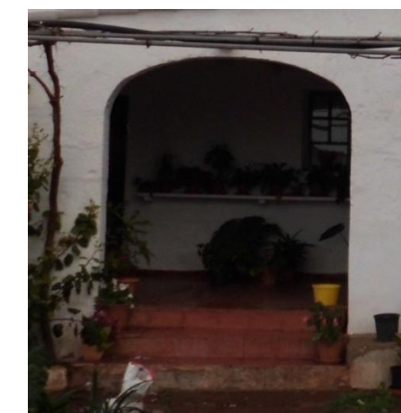
Fig. 21. Exemple d'un arc aixecat de l'edifici 1
