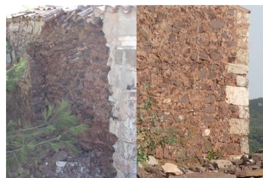
Fig.99. Enderroc paret Fig.100. Marès a les cantonades
