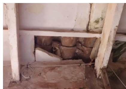
Fig.98. Teules amorterades
