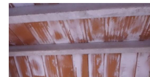
Fig.88. Coberta a edifici 2
