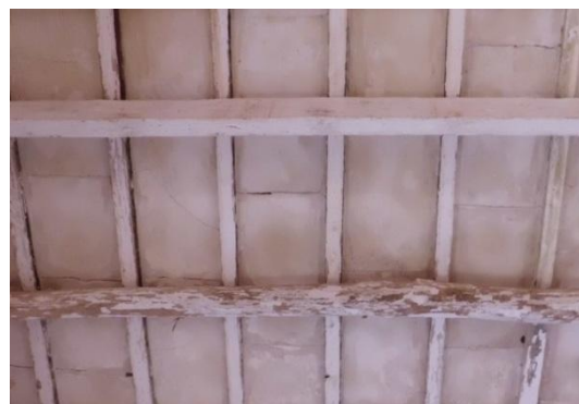
Fig.71. Forjat amb fires de fusta i quars de marès
