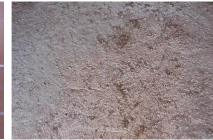
Fig. 39. Solera sense pavimentar
