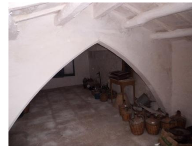
Fig.94. Coberta a edifici 1
