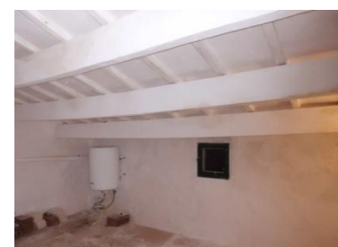
Fig.81. Coberta a edifici 1
