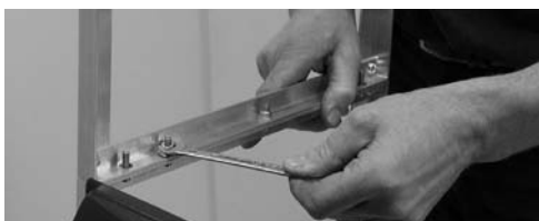
Montaje del soporte de la consola
