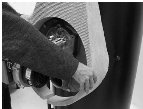
Colocación del aislante trasero de la brida
