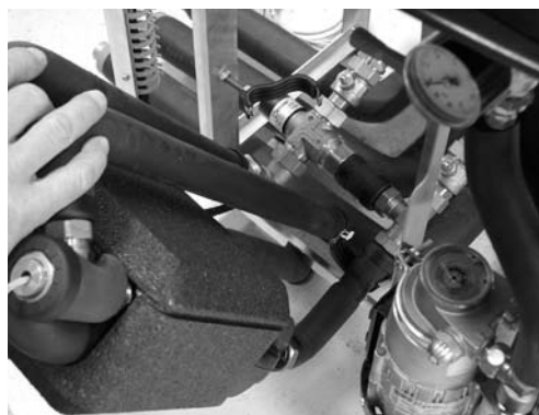
Introduzca la estación de agua caliente sanitaria con grifo esférico
