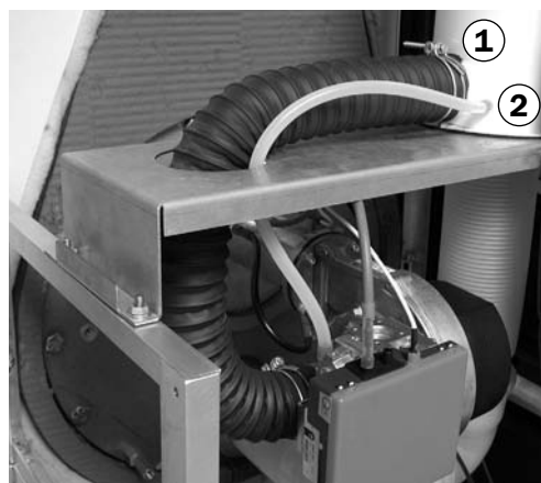
Tubo de entrada de aire y tubo de compensación de presión montados
