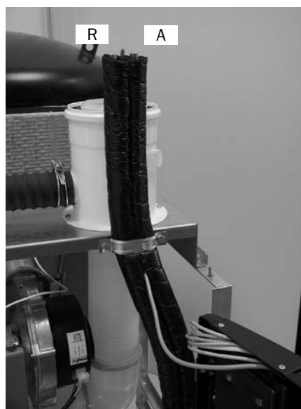
Tubo de montaje rápido con avance y retorno y cable del sensor dirigido hacia arriba
