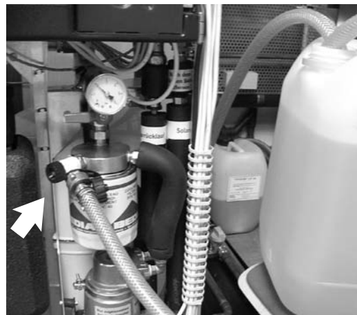
Manguera de llenado conectada al grifo de llenado
