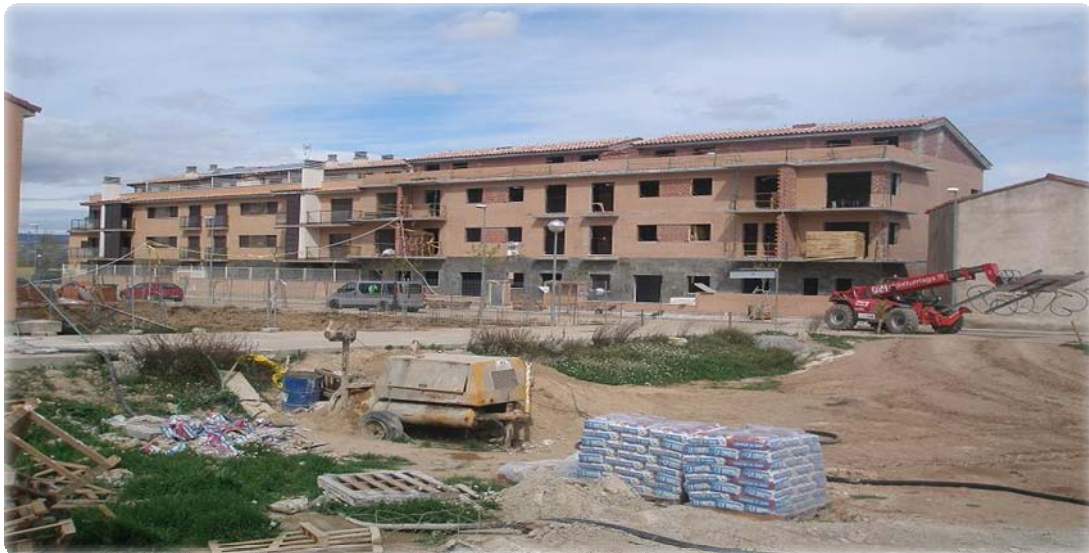
Abassegament de residus i material de l'obra in situ
