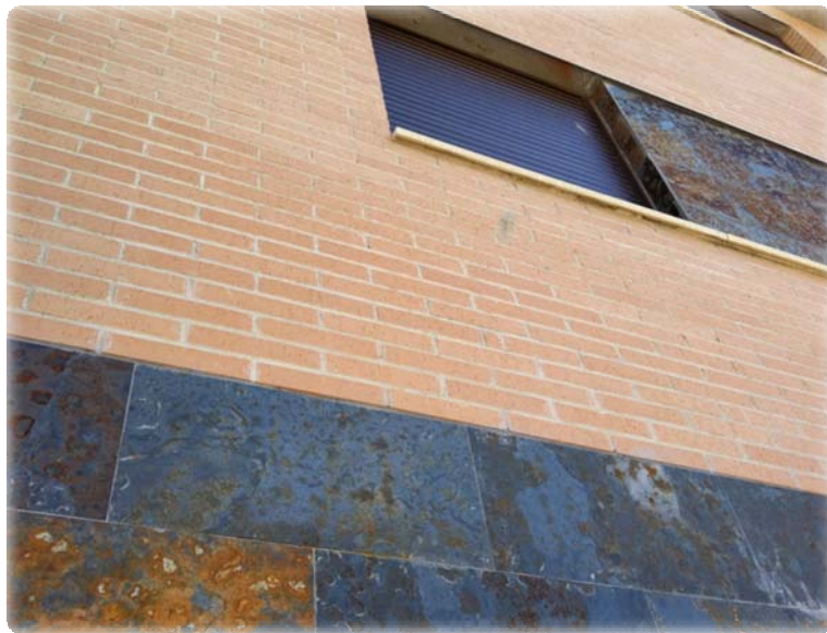
Detall façana (maó perforat cara vista, revestiment de pissarra)
