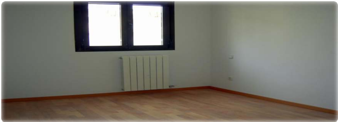
Terra de parket, alumini en finestres i radiadors instal·lats
