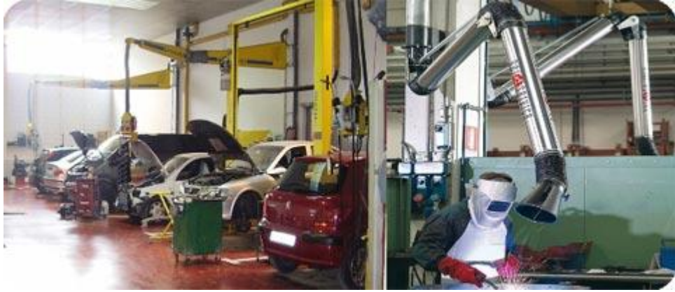
Fig. B.6. a) Unitat autònoma d'aspiració de gasos b) Braç aerí d'extracció de gasos
