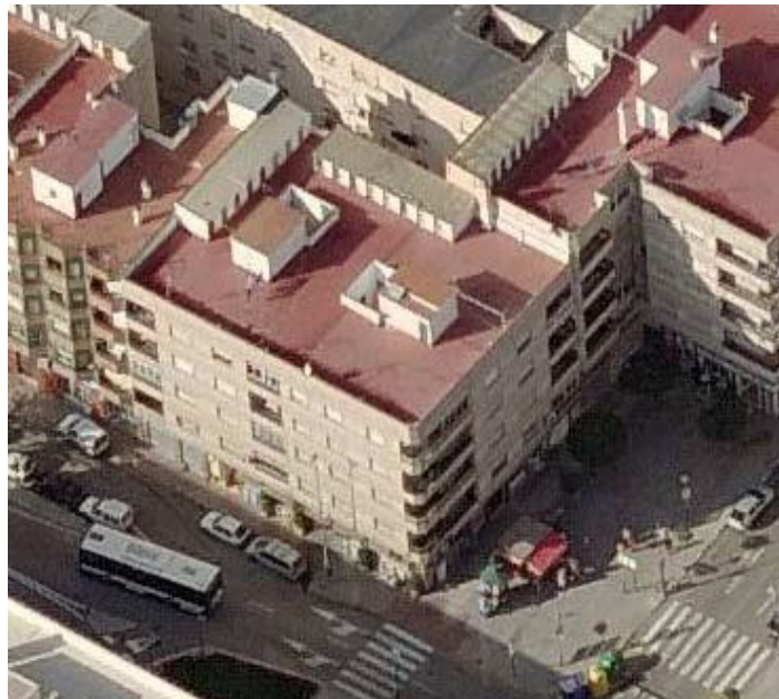
Figura 3-8. Edificio de viviendas y locales, La Viña.
