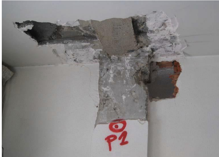
Figura 3-14. Nudo viga – pilar 1.
