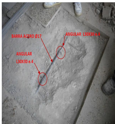
Figura 3-11. Vista superior cata en jácena.
