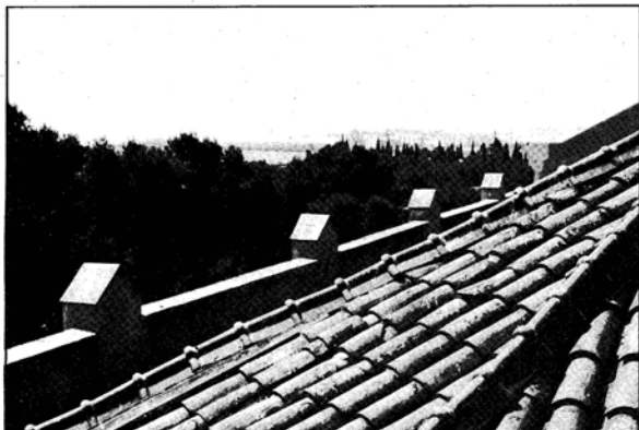
Les obres fa dues setmanes que s'han iniciat.
