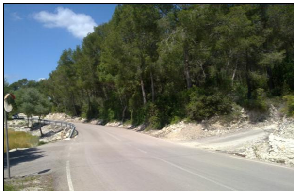
Figura 5.3.2.: carretera MA-3230 al W
