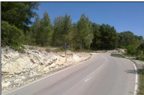
Figura 5.3.1.: carretera MA-3230 al E
