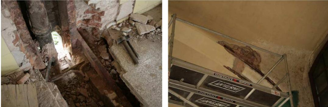
Imagen 7: Calas efectuada en pilares techo de planta primera. A la izquierda nudo entre tirantes y pilar. A la derecha perfiles embebidos en el arco.
