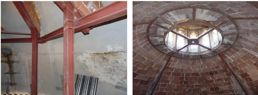
Imagen 8: Cúpula de la zona de día. Izquierda estructura de apuntalamiento. Derecha perfilería original embebida.
