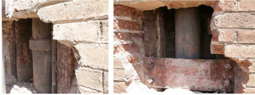
Imagen 6: Calas efectuada en pilares embebidos en fachada en la nave central.
