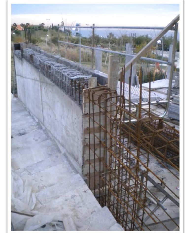
Hormigonado del muro Norte por tramos
