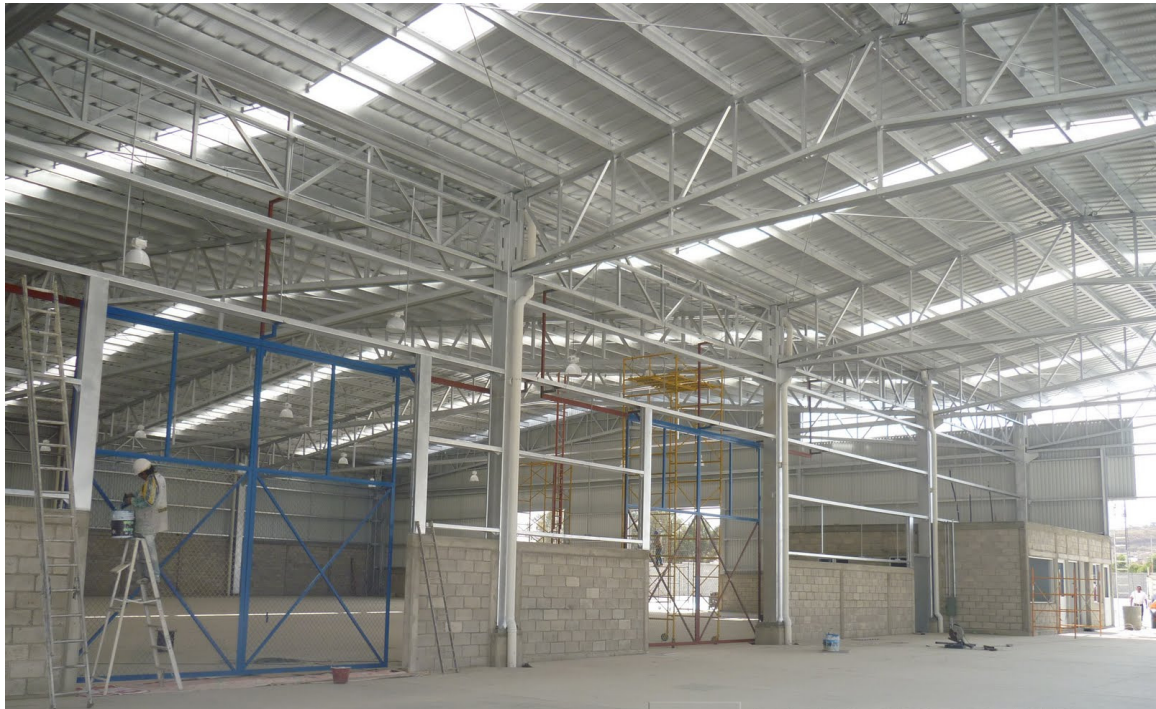
Figura 8.11: Interior de una nave tipo
