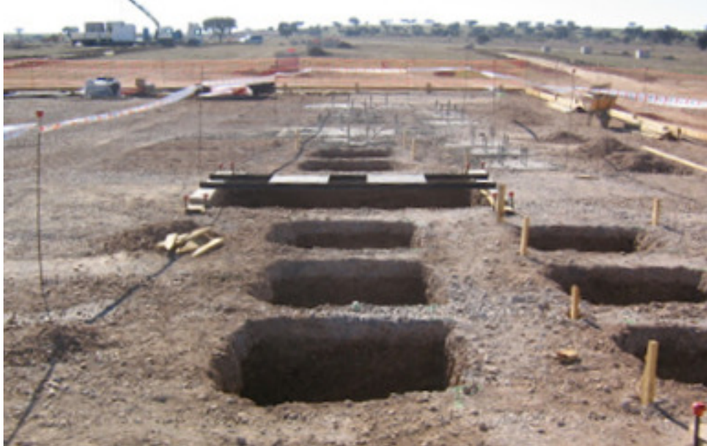
Figura 8.8: Pozos para zapatas
