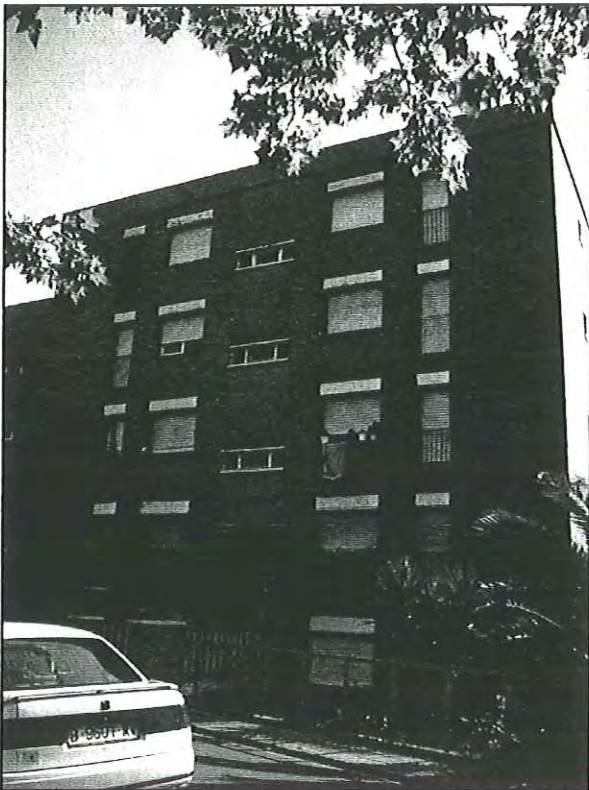
Façana principal Passatge escoles 5
