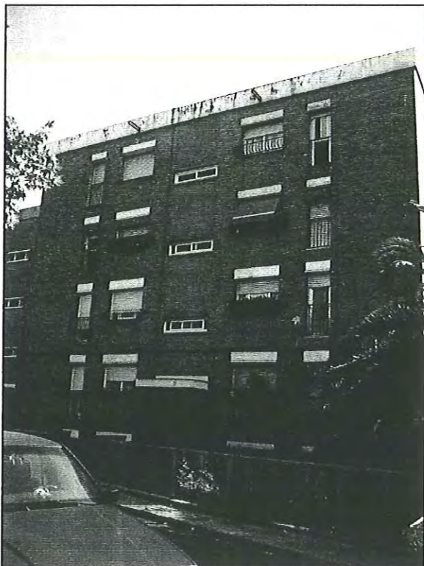
Façana principal Passatge escoles 11
