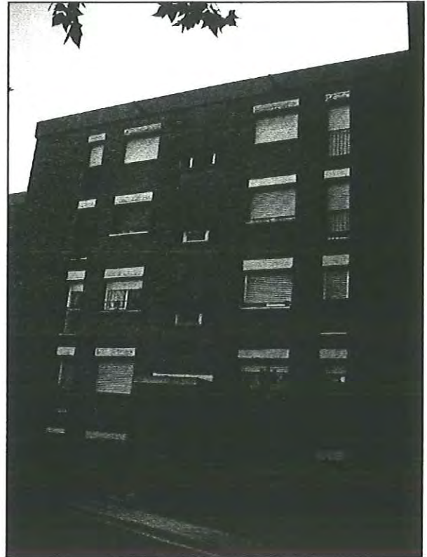
Façana principal Passatge escoles 7
