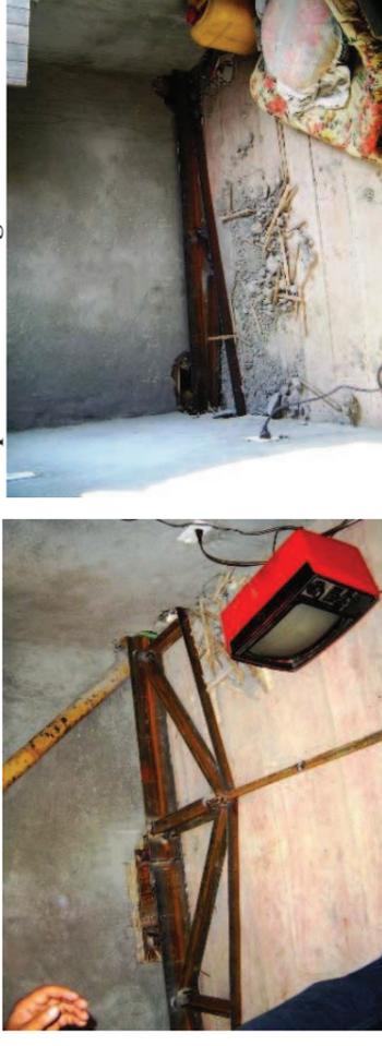
La cercha se encuentra anclada a la estructura principal de la vivienda por medio de un perfil en L que recorre longitudinalmente todo el muro y va soldado a la cercha.
