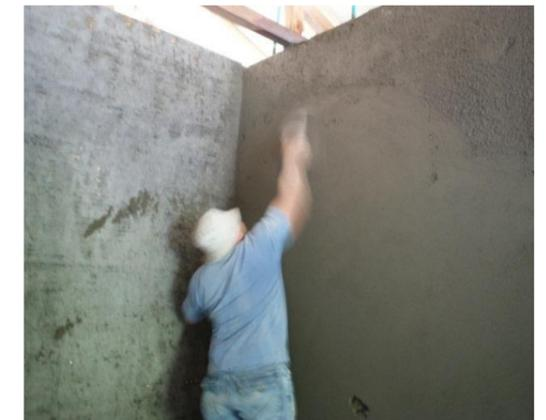
Figura 4.31. Recubrimiento de esterilla de guadua y malla de alambre, forjado al descubierto. Archivo personal.
