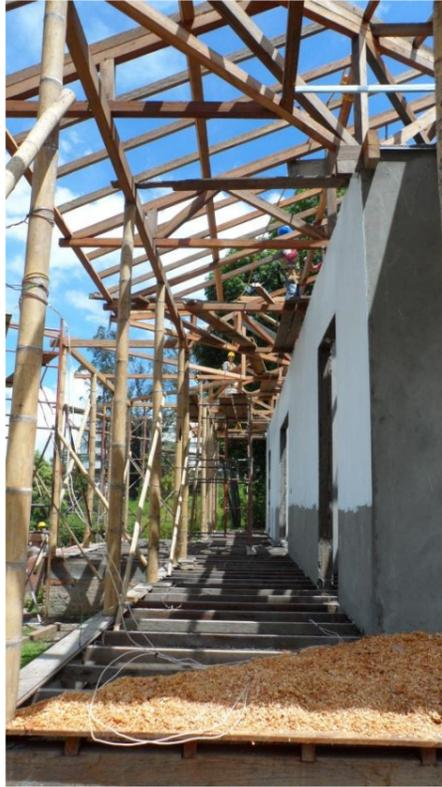
Figura 4.25. Cubierta y forjado en madera, Manizales. Archivo personal.
