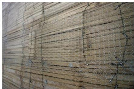
Figura 4.27. Detalle esterilla guadua y fijación de la malla, Manizales. Archivo personal.
