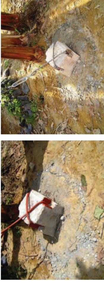
En la fotografías aparecen los muertos 1 (izquierda) y dos (derecha), consistentes en dos bloques de concreto reforzado de 1.2 m de profundidad y conectados por una viga de cimentación a manera de contrafuerte.
