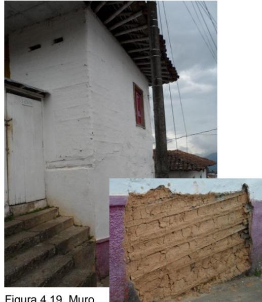
Figura 4.19. Muro al descubierto, bahareque en tierra, Salamina. Archivo personal.
