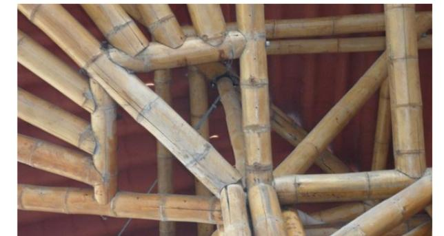
Figura 4.5. Estructura en guadua, uniones reforzadas en mortero y pernos, Terminal de Neira. Archivo personal.
