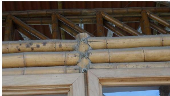
Figura 4.6. Estructura en guadua, uniones reforzadas en mortero y pernos, Terminal de Neira. Archivo personal.
