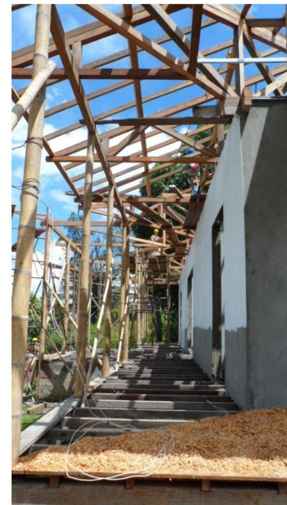
Figura 3.24 Construcción en Bahareque encementado, La Alhambra, Manizales. Archivo personal.
