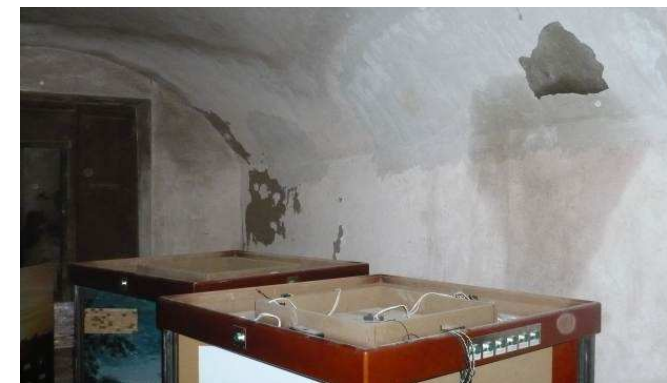
Imatge 174: Humitats en la volta de planta baixa
