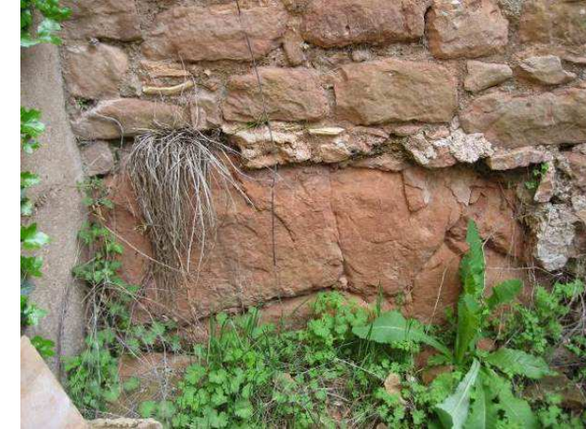
Imatge 54: Paret de càrrega recolzada sobre la roca 1
