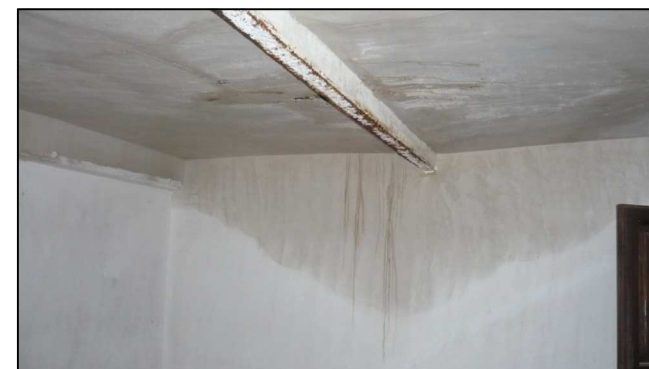
PERFIL AFECTAT PER LA CORROSIÓ I HUMITAT GENERALITZADA EN L'ENCANYISSAT
