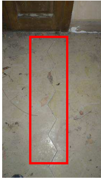
Imatge 152: Obetura de la junta entre les rajoles
