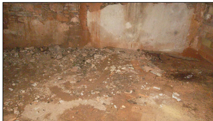
ESTAT DEL PAVIMENT
