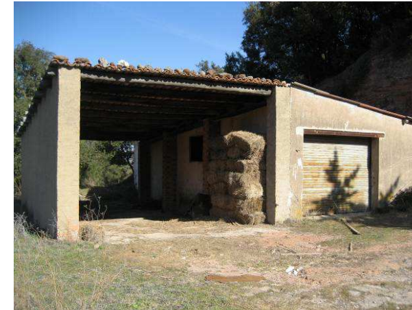
Imatge 26: Vista de la cara sud. Porxo i garatge adossat de nova construcció
