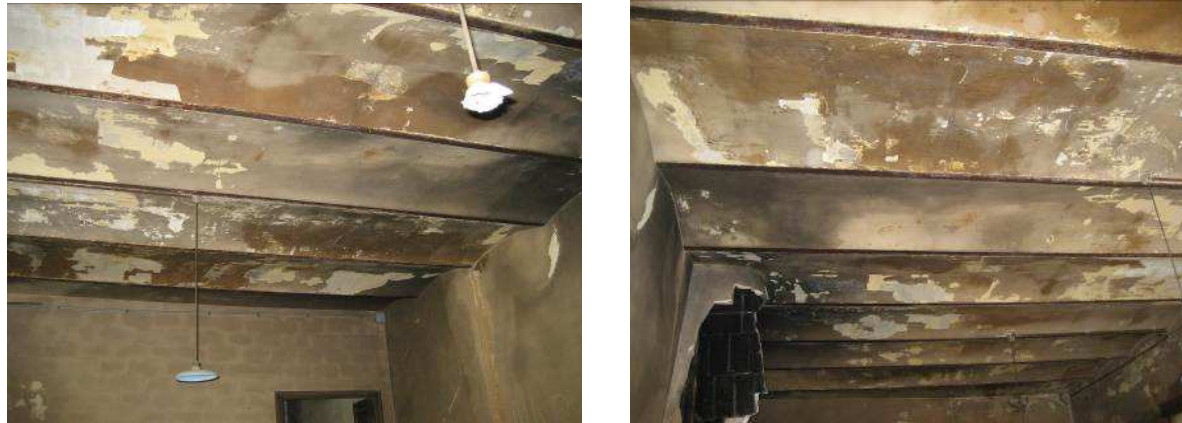
Imatges 194 i 195: Estat de l'acabat del sostre del menjador
