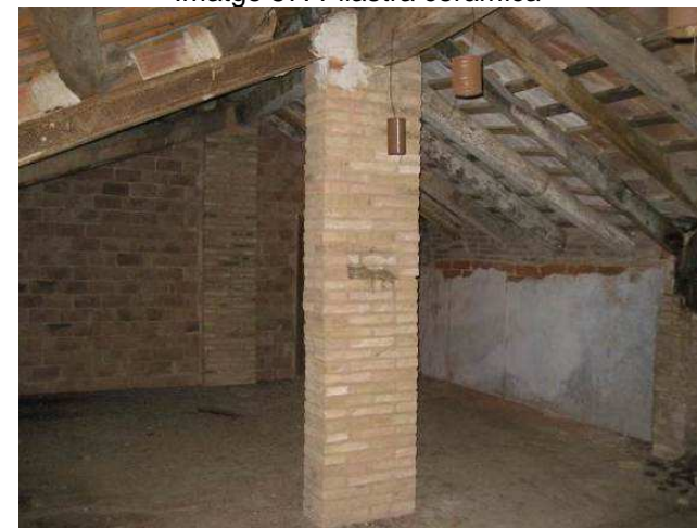
Imatge 58: Pilar ceràmic en planta sotacoberta
