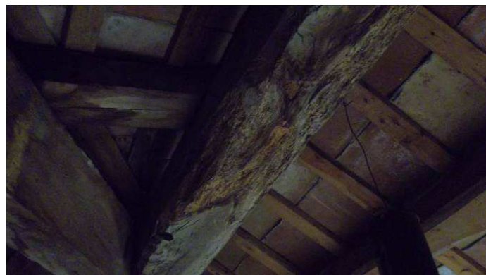
Imatge 156: Biga que conforma el carener, afectada pels corcs
