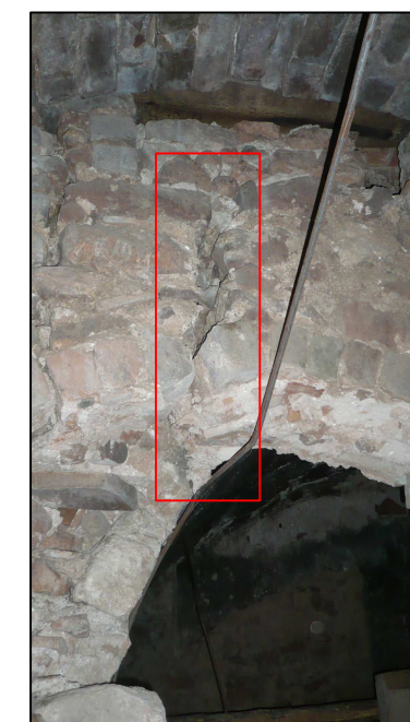
ESQUERDA VERTICAL EN EL MUR
