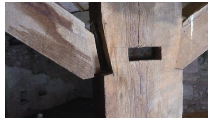
Imatge 208: Desenganx entre pendeló i tornapunta
