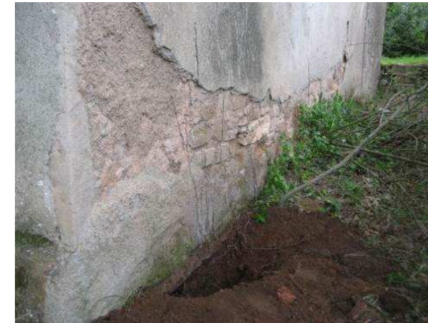
Imatge 49: Vista general de la cala 2
