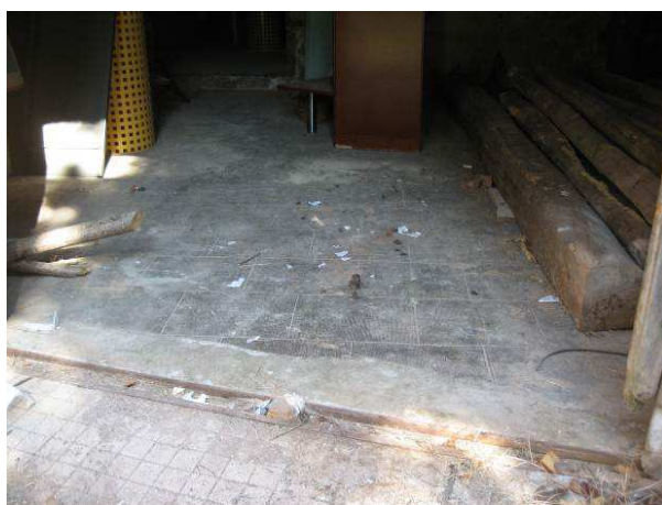
Imatge 69: Paviment continu de morter esbuixardat
