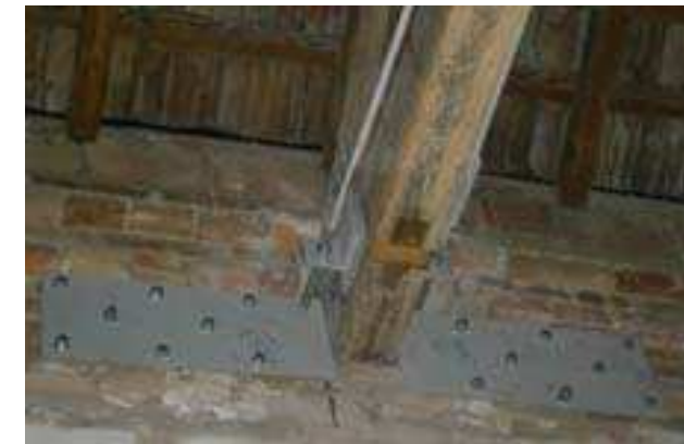
Imatge 216: Tensor metàl·lic col·locat en un dels recolzaments 2
