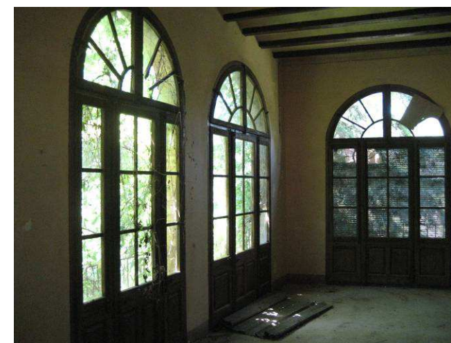
Imatge 38: Galeria afegida a la façana principal
