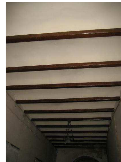
Imatge 63: Vista inferior del forjat del distribuïdor principal
