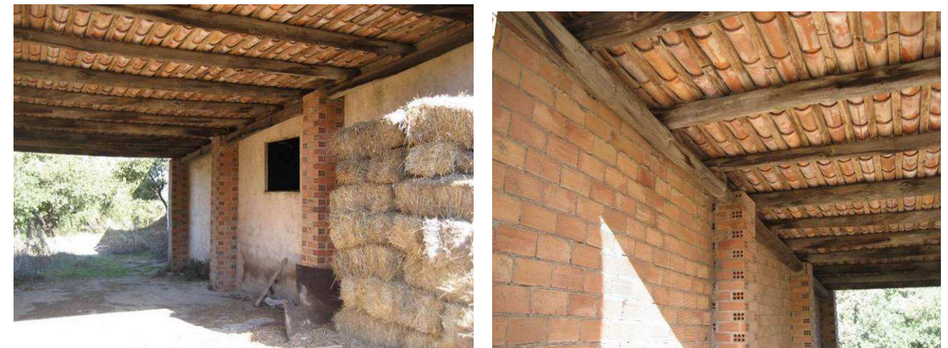
Imatge 27 i 28: Estructura i coberta del porxo
