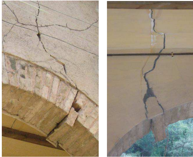
Imatge 184 i 185: Arribada de l'esquerda a l'arc ceràmic i esquerra vista per la cara interior
