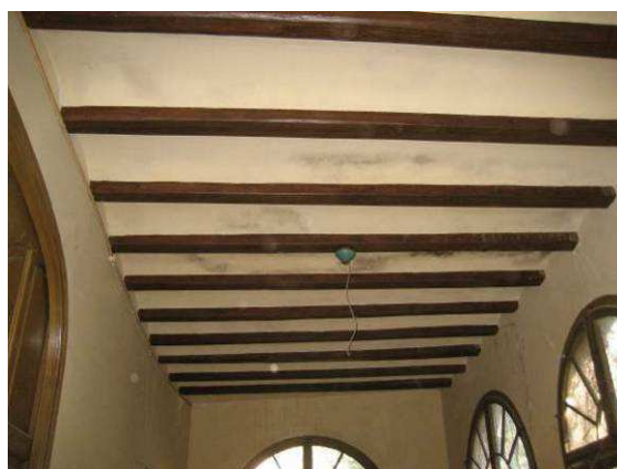
Imatge 90: Acabats en el sostre de la galeria
