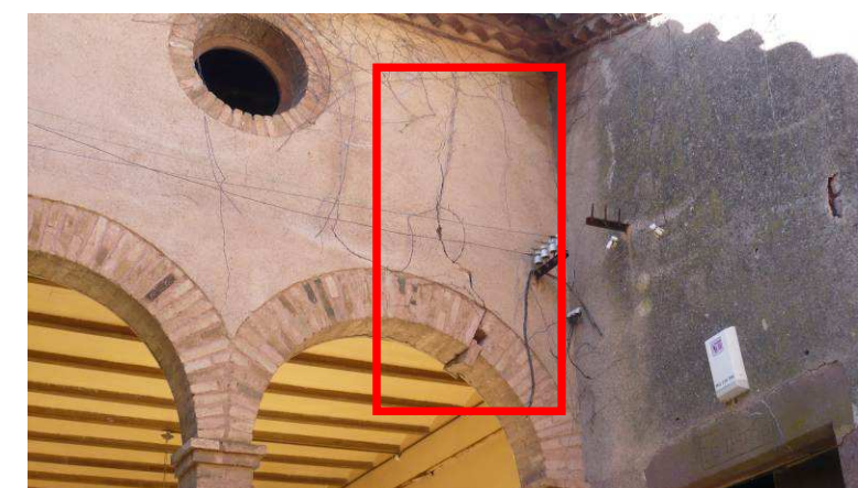
Imatge 182: Esquerda vista desde l'interior en planta sotacoberta
