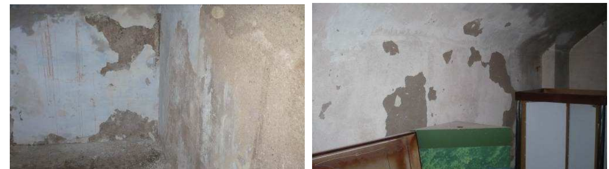
Imatges 138-139-140-141: Humitats en la part oest i la volta del cos central
