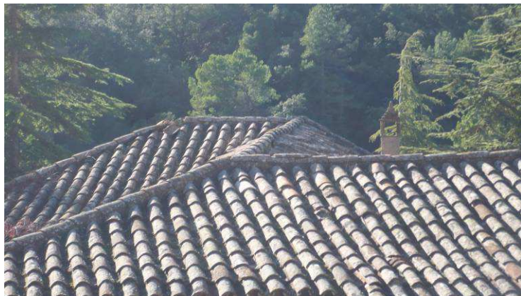
Imatge 41: Canvi de direcció del carener en la part ampliada
