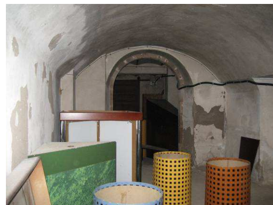
Imatge 34: Cos central amb la volta de canó
