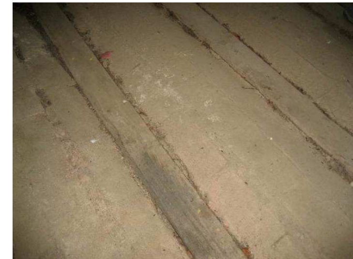
Imatge 64: Vista del forjat per la cara superior
