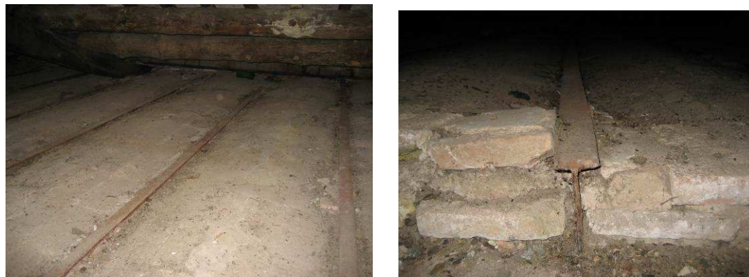
Imatge 150 i 151: Vista dels perfils metàl·lics per la seva cara superior
