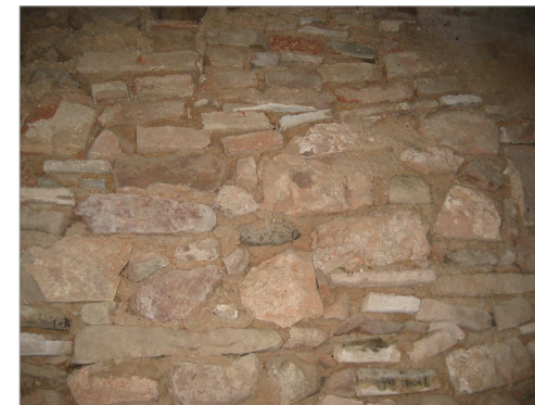
Paret de maçoneria
