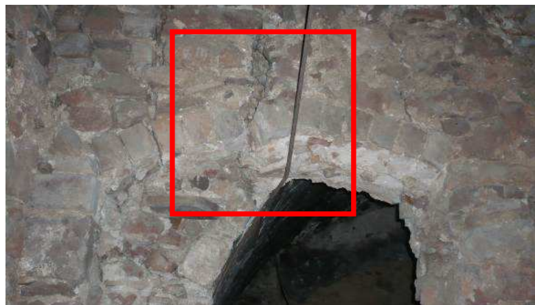
Imatge 145: Esquerda vertical en una paret del celler
