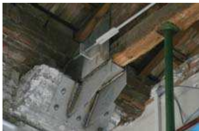
Imatge 215: Tensor metàl·lic col·locat en un dels recolzaments
