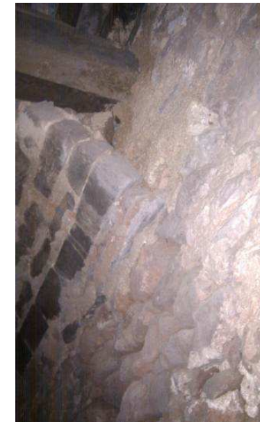
Imatge 143: Arrancada de la volta del celler
