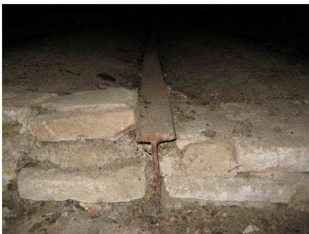
Imatge 6: Detall d'un perfil metàl·lic d'ala estreta
