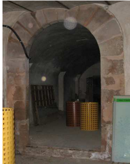
Imatge 103: Arc de mig punt d'accés al cos central
