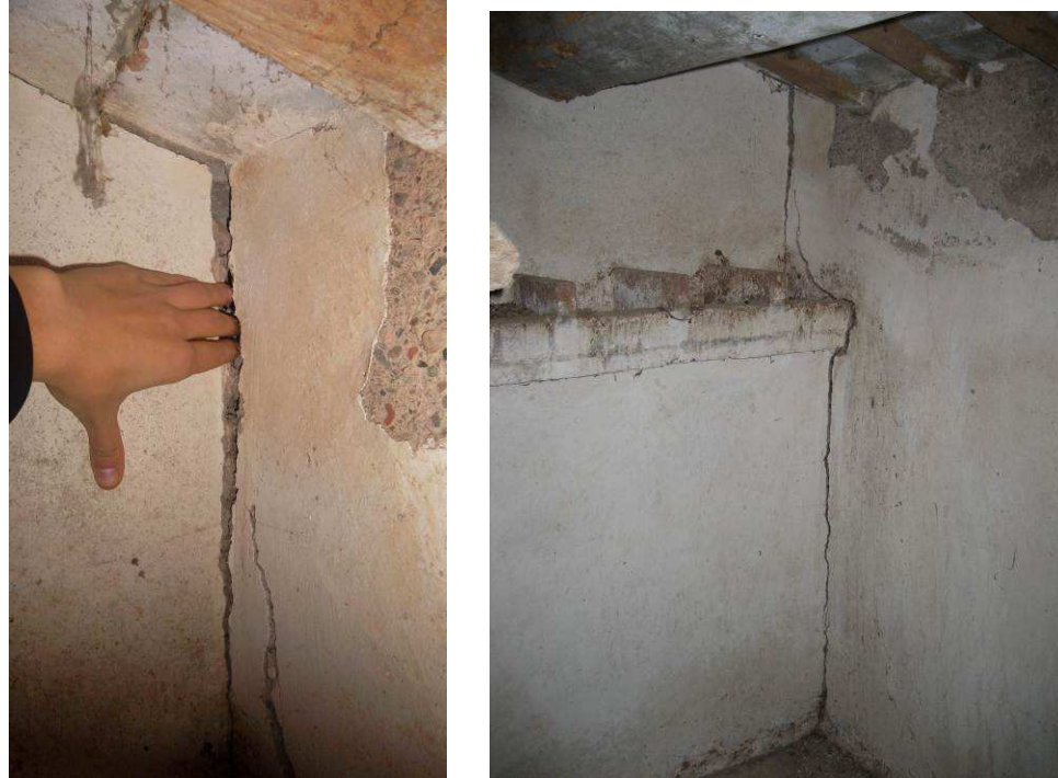
Imatges 164 i 165: Esquerda en una cantonada del colomer
