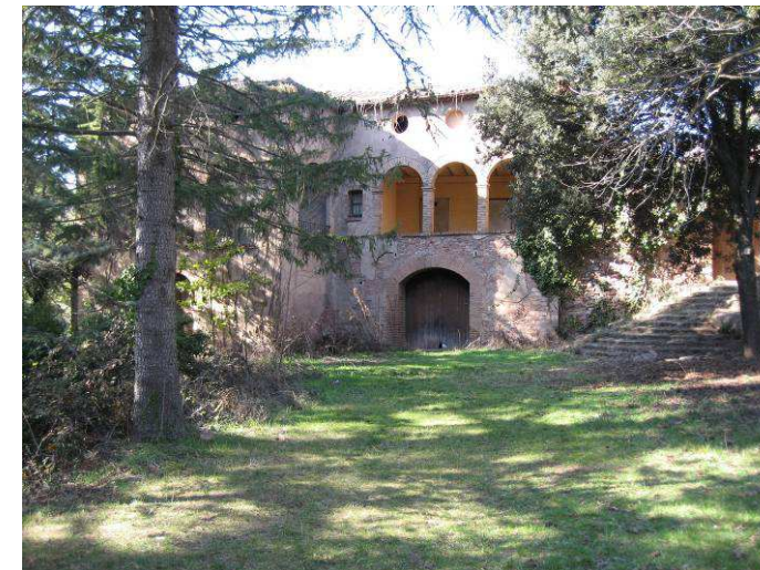
Imatge 42: Façana sud (principal)
