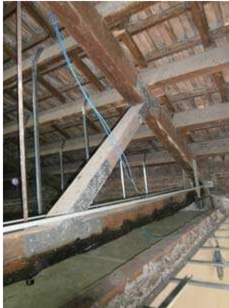
Imatge 210: Platines metàl·liques de reforç en els nusos de l'encavallada
