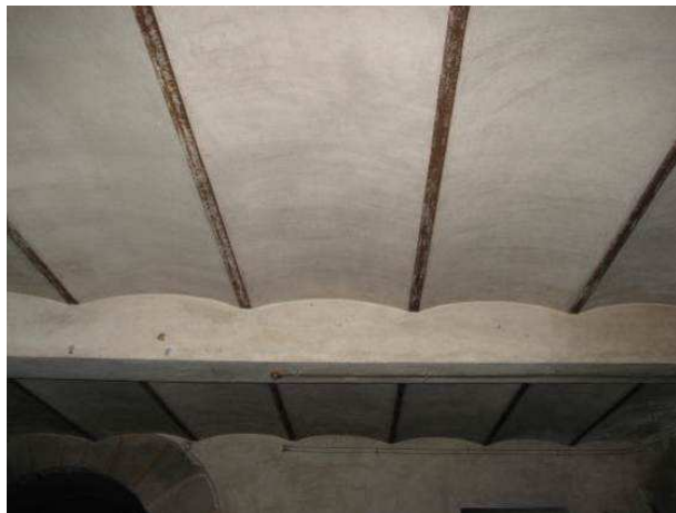
Imatge 65: Forjat del porxo d'entrada de PB
