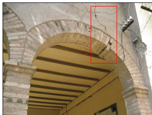
ESQUERDA FINALITZANT EN L'ARC
