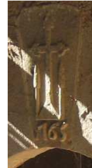
Imatge 96: Detall de la dovella superior de l'arc
