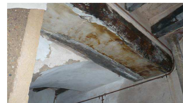
Imatges 175 i 176: Humitats en la doble jàssera de la zona dels banys de planta baixa
