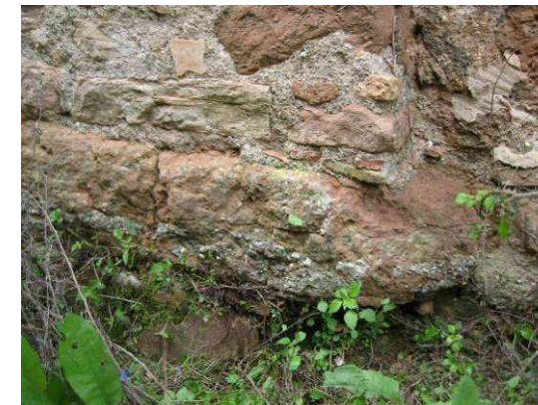
Imatge 55: Paret de càrrega recolzada sobre la roca 2
