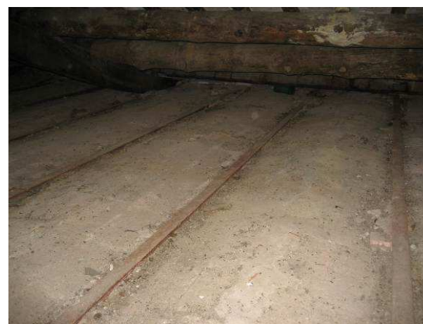
Imatge 68: Vista superior d'un forjat amb biguetes metàl·liques
