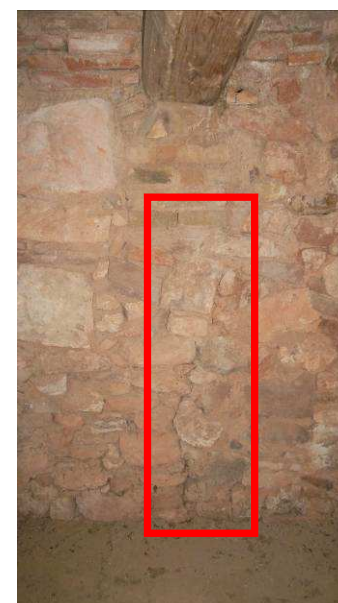
Imatge 182: Esquerda vista desde l'interior en planta sotacoberta
