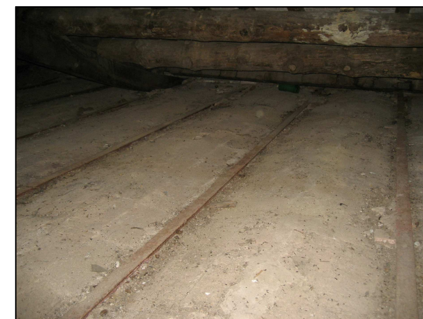
VISTA DEL FORJAT DESDE PLANTA SOTACOBERTA
