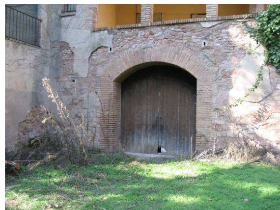
Imatge 33: Entrada a la planta baixa
