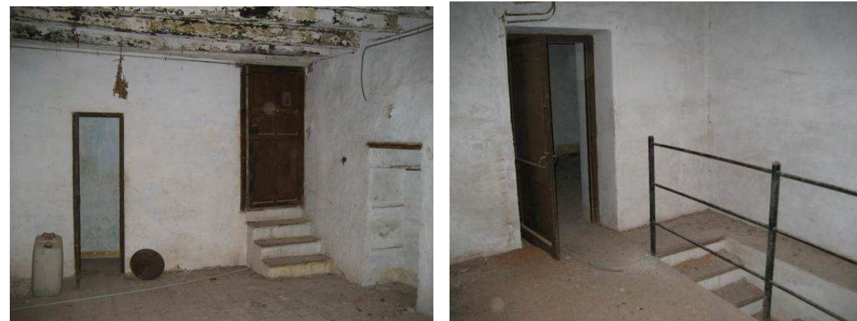
Imatge 80 i 81: Acabats en l'accés a sotacoberta i el distribuïdor 2
