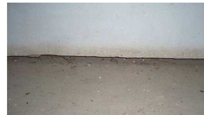
Imatge 133: Separació entre el paviment i una paret divisòria en planta primera
