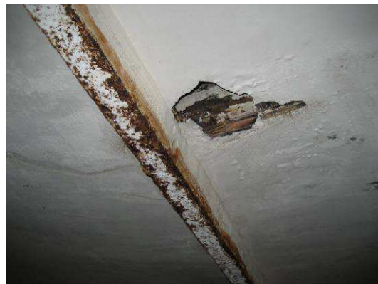
Imatge 169: Estat en què es troben l'encanyissat i el perfil metàl·lic
