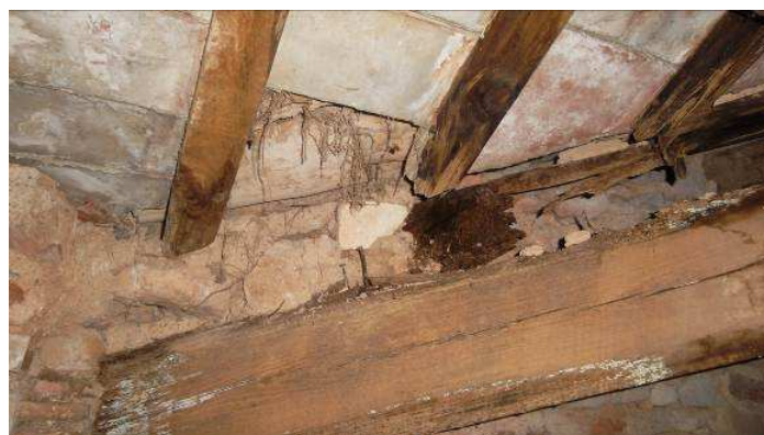
Imatge 181: Vista de l'aiguafons per la part inferior
