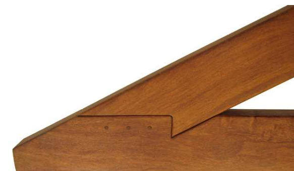
Imatge 217: Unió entre cavall i tirant en un recolzament
