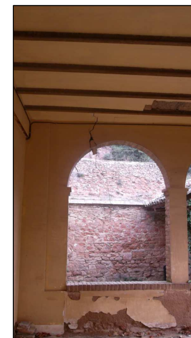
VISTA GENERAL ESQUERDA INTERIOR MUR
