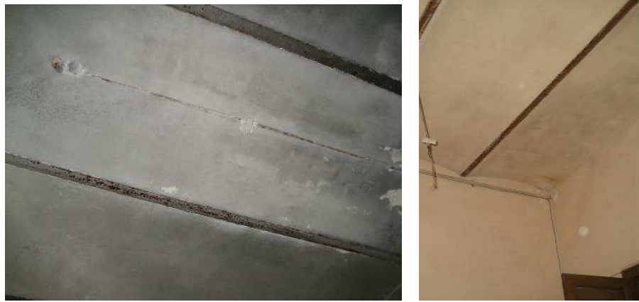
Imatge 148 i 149: Corrosió en perfils metàl·lics de forjats de planta primera
