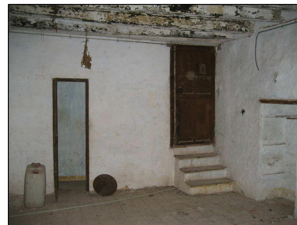
ESTAT ACTUAL DEL PAVIMENT
