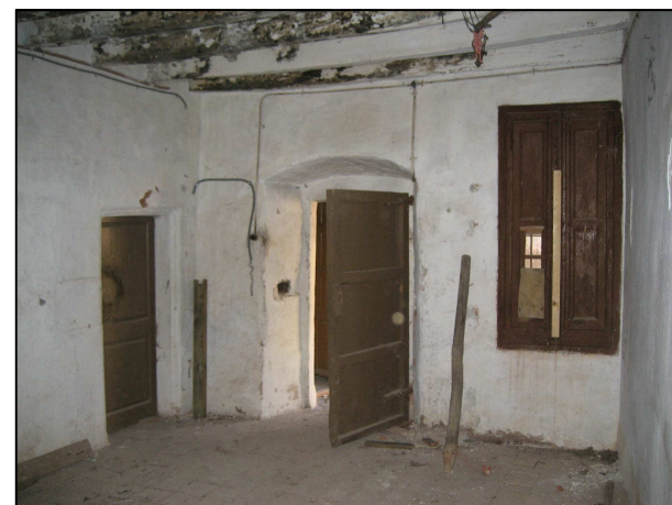
ESTAT ACTUAL DEL PAVIMENT
