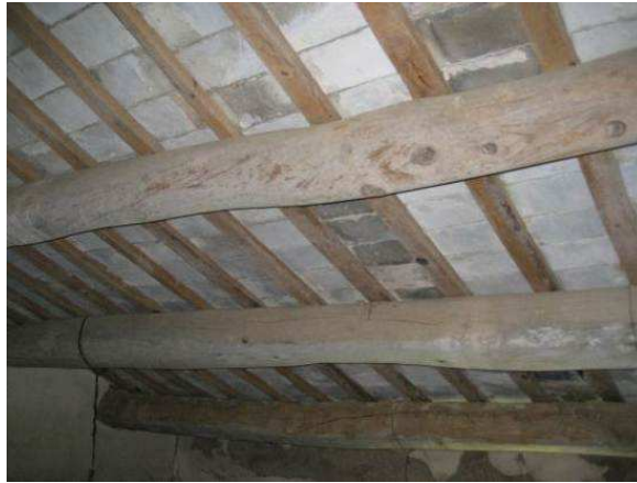
Imatge 94: Vista inferior de la coberta
