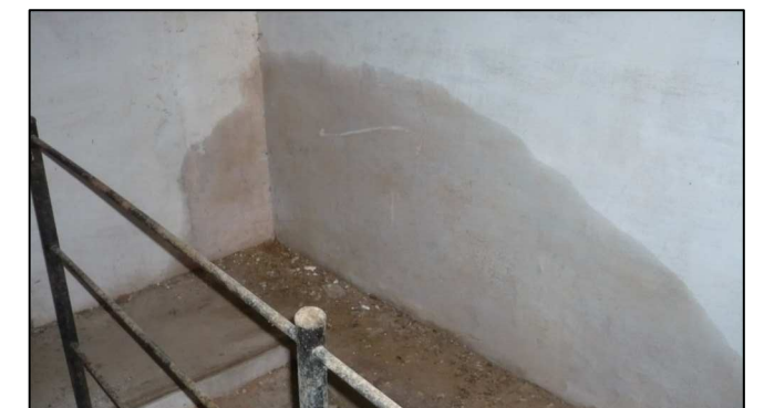
HUMITATS PER FILTRACIÓ I CAPIL·LARITAT, APAREGUES EN L'ESCALA
