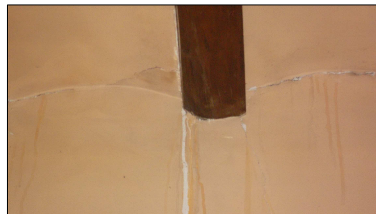
DETALL ESQUERDA VERTICAL
