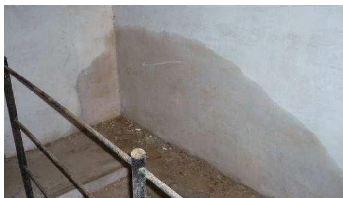
Imatge 173: Humitats en l'escala d'accés a planta primera
