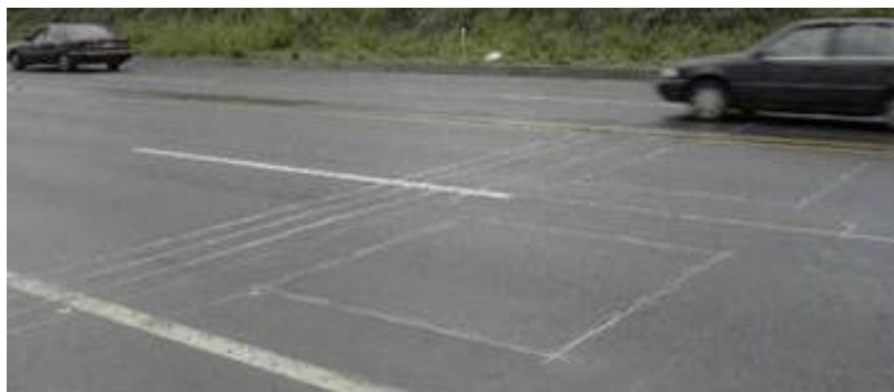
Figura 2.11. Sensor por espiras magnéticas
