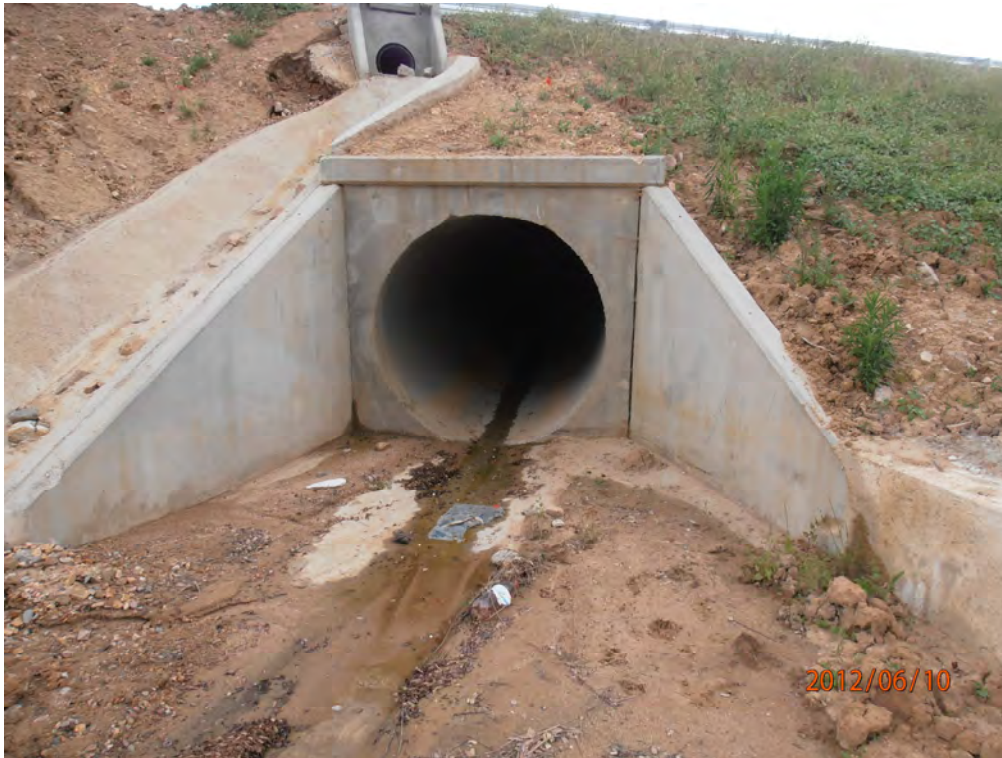
27. Ampliació ODT 230.71 (existent) sentit Lleida
