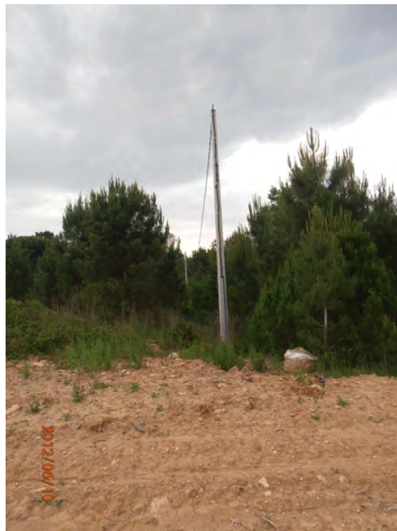
24. Servei afectat nº100, costat nord
