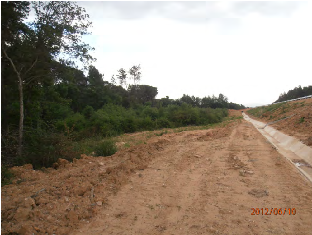
23. Panoràmica ubicació de l'àrea de servei, costat nord, des del nord-oest (4 de 4)
