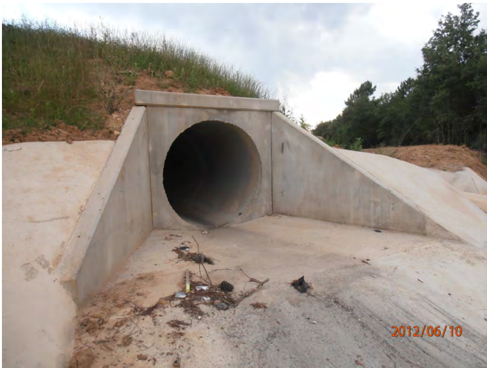
26. ODT 0.0 Ampliació executada sota ramal. Sentit Lleida
