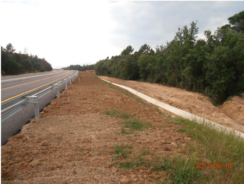
25. Preparació ramal entrada a l'àrea de servei sentit Lleida
