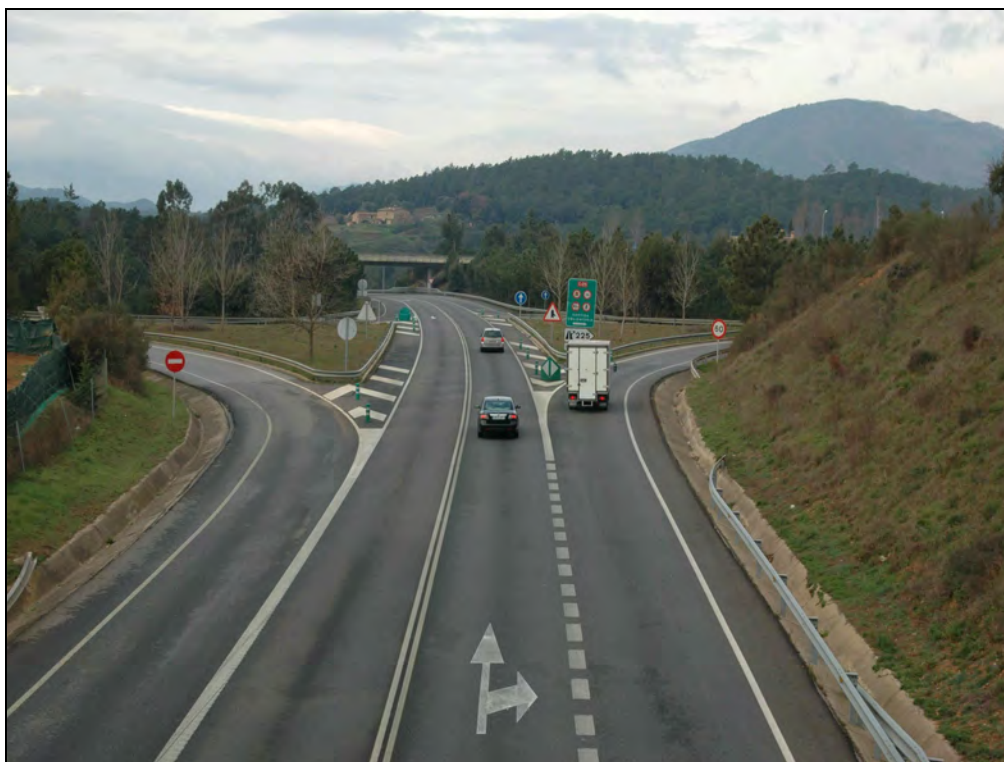
29. Carretera C-25 enllaç amb la C-63 sentit Lleida des de P.S. 225.4
