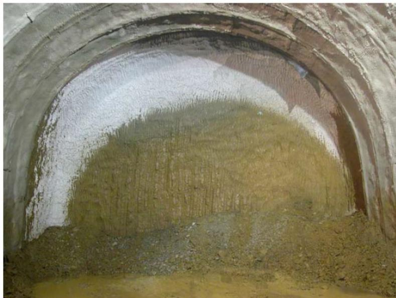
**Figura 2.9** Aspecto de la toba con la congelación de un espesor considerable de terreno claramente evidente (Colombo et al 2008).
