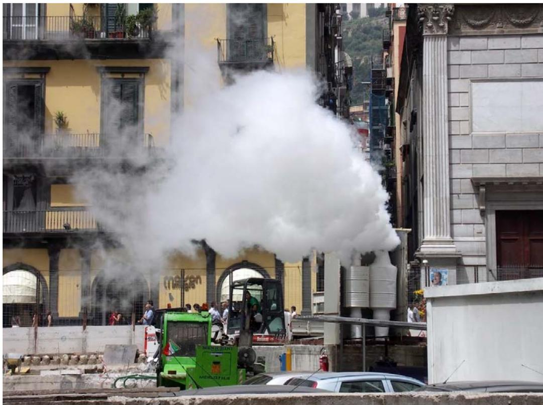
**Figura 2.8** Expulsión del nitrógeno líquido a la atmosfera a temperatura entre  $-100^{\circ}\text{C}$  y  $-60^{\circ}\text{C}$ . (Studio Cavuoto en [www.studiocavuoto.com](http://www.studiocavuoto.com)).
