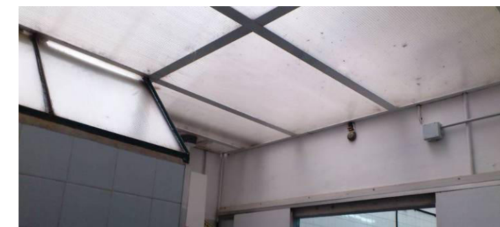
Fig.6.2: Lluerna policarbonat interior Cuina Font: Elaboració pròpia – ANNEX B Arxiu fotogràfic
