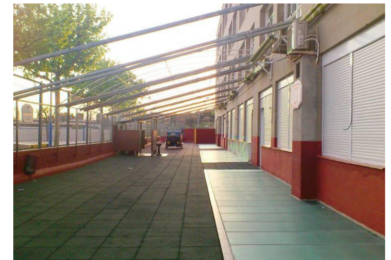
Fig.4.2: Vista general pati parvulari, lluernari transitable Font: Elaboració pròpia
