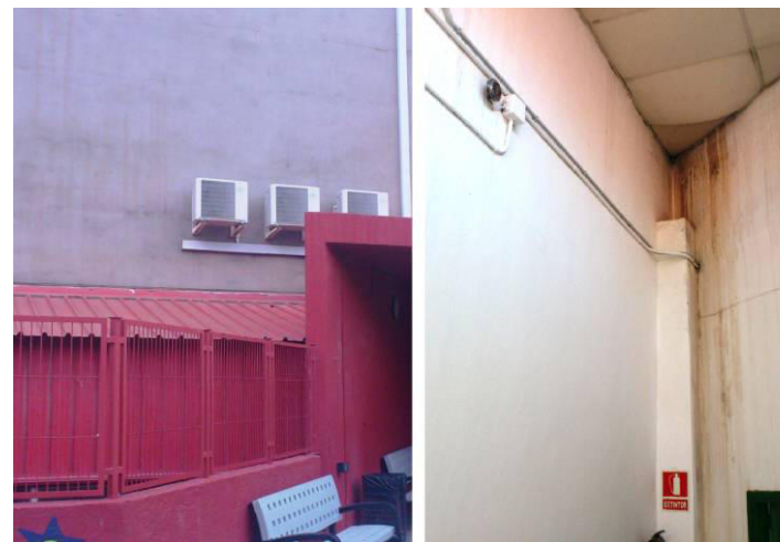
Fig.6.4: Coberta xapa grecada A. Música, lesions Fals Sostre Font: Elaboració pròpia – ANNEX B Arxiu fotogràfic
