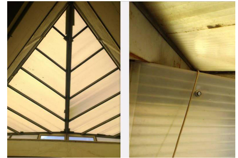
Fig.4.1: Vista inferior i detall, lluernari policarbonat coberta Font: Elaboració pròpia
