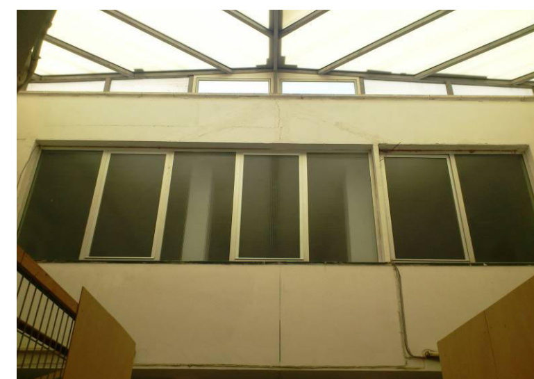
Fig.4.17: Vista interior lluerna policarbonat, fusteria PVC aula A48 Font: Elaboració pròpia
