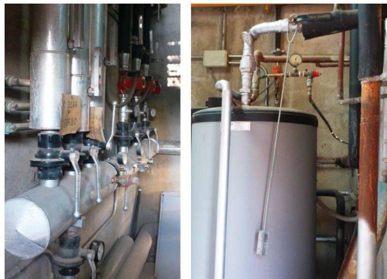
Fig.4.21: Col·lectors generals calefacció, ACS, dipòsit 300 L Font: Elaboració pròpia
