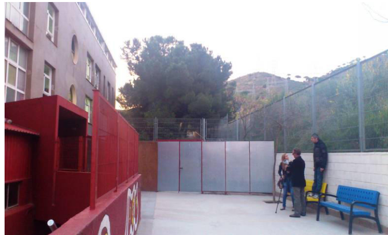
Fig.4.13: Vista exterior pati, façana Nord-est, sostre exterior Font: Elaboració pròpia
