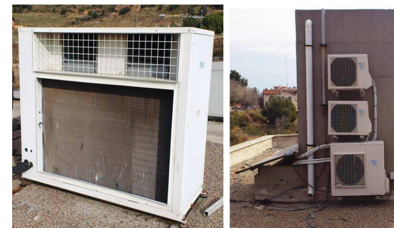
Fig.4.24: Equip exterior biblioteca, resta equips exteriors coberta Font: Elaboració pròpia
