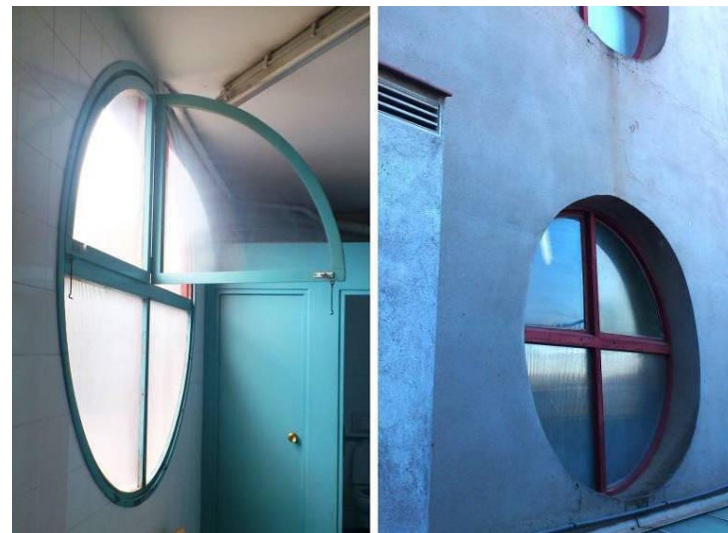
Fig.6.10: Finestres de fusta, excessiva permeabilitat a l'aire Font: Elaboració pròpia – ANNEX B Arxiu fotogràfic
