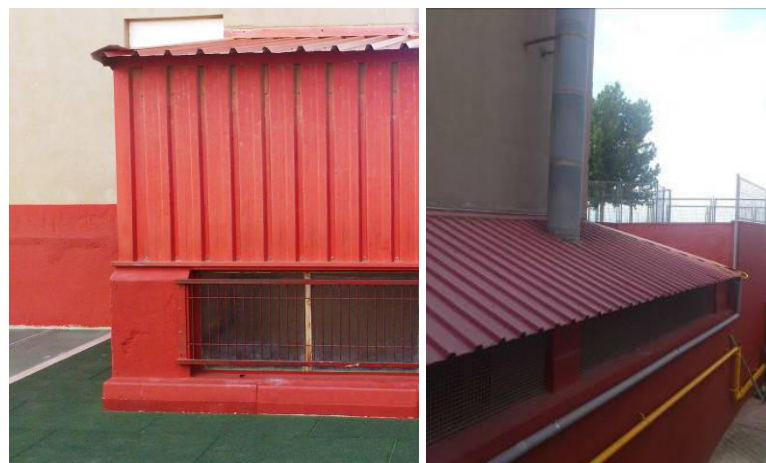
Fig.5.33/34: Cobertes de xapa grecada, transició entre façanes Font: Annex fotogràfic. Elaboració pròpia
