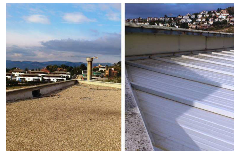
Fig.4.16: Vista exterior coberta no transitable, coberta inclinada Font: Elaboració pròpia
