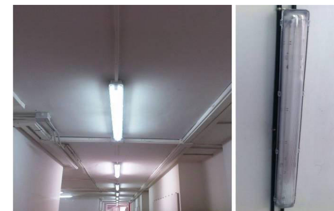
Fig.6.15: Substitució d'equips antics per làmpades estanques Font: Elaboració pròpia – ANNEX B Arxiu fotogràfic
