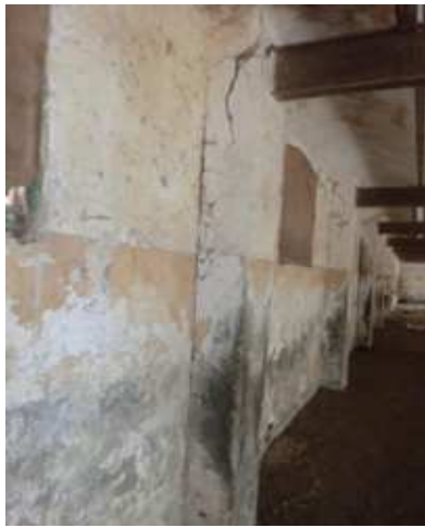
Foto 10: Esquerda obliqua en una de les pilastres de maó.
