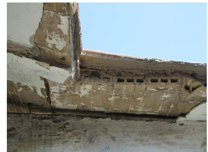
Foto 33: Composició del forjat que suporta la coberta plana, amb una sola capa de maó perforat.
