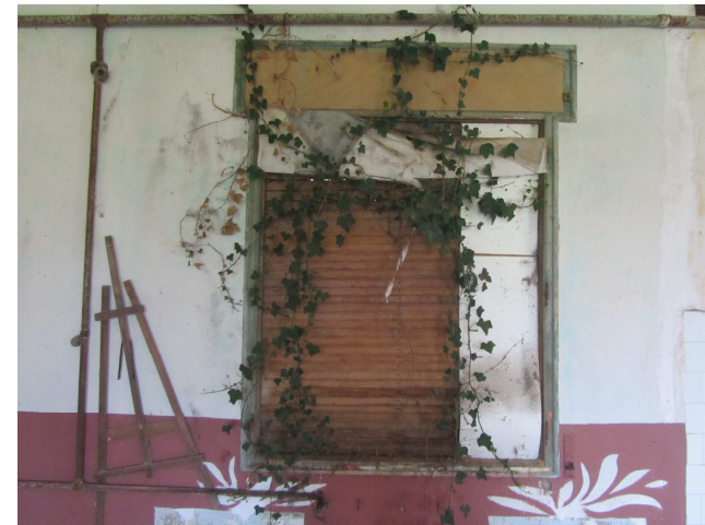
Foto 28: La vegetació (heura) ha penetrat, en alguns casos, en les finestres i forats de persiana.
