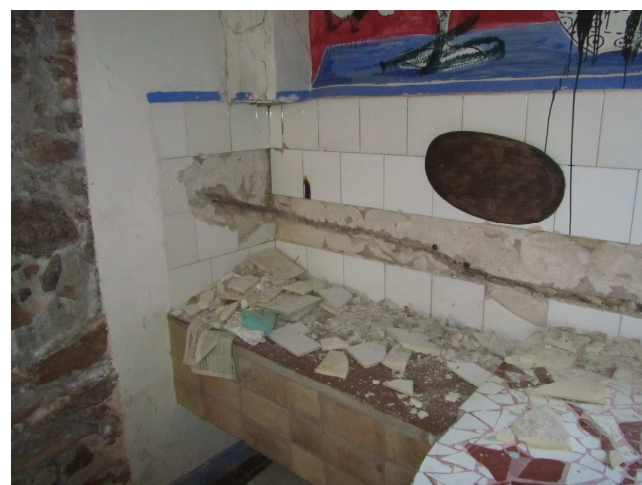
Foto 43: Robatori de les canonades d'aigua, que provoca humitats i trencaments dels acabats.
