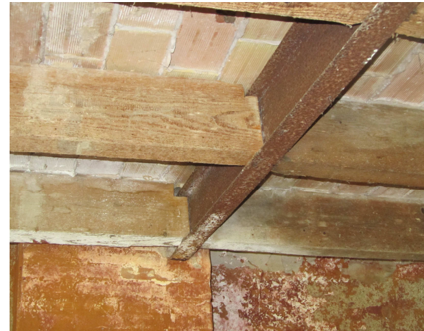
Foto 13: Bigues de fusta que recolzen uns 2cm en el perfil metàl·lic central.
