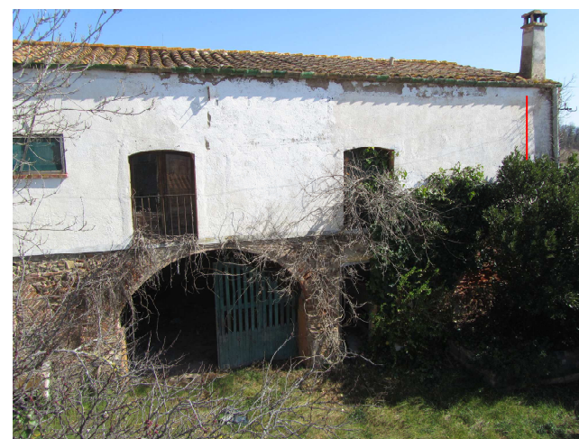
Foto 6: Esquerda vertical en la façana oest del tercer volum.
