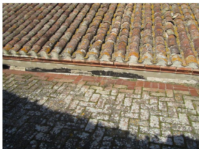
Foto 36: Coberta plana transitable amb làmina asfàltica col·locada posteriorment.
