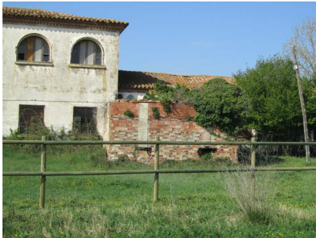
Foto 11: Vista general de la coberta de l'annex E.
