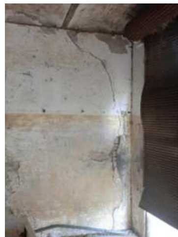
Foto 13: Interior de la façana Est, on s'hi observa la mateixa esquerda.
