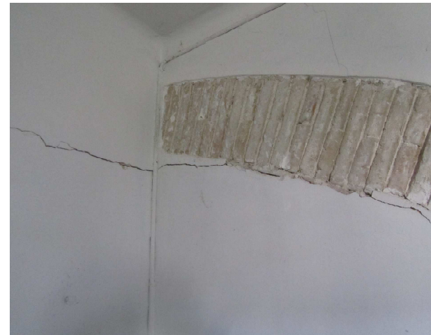
Foto 11: Esquerda horitzontal en la trobada entre l'arc i la divisòria interior.
