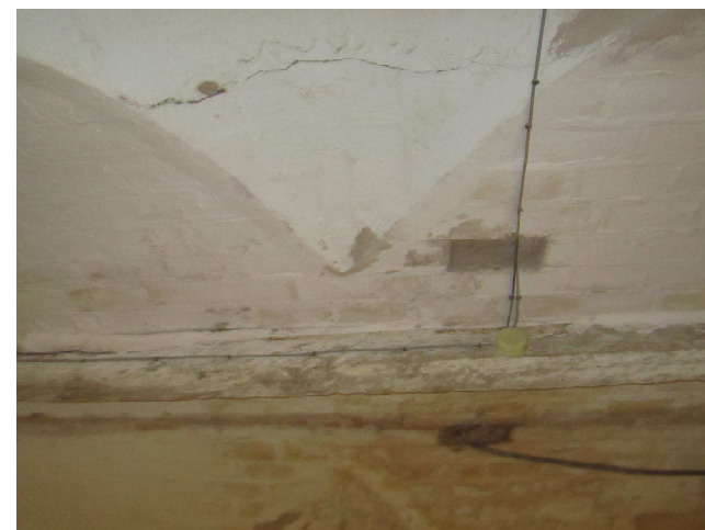
Foto 29: Detall de l'esquerda horitzontal en la lluneta de la volta ceràmica.
