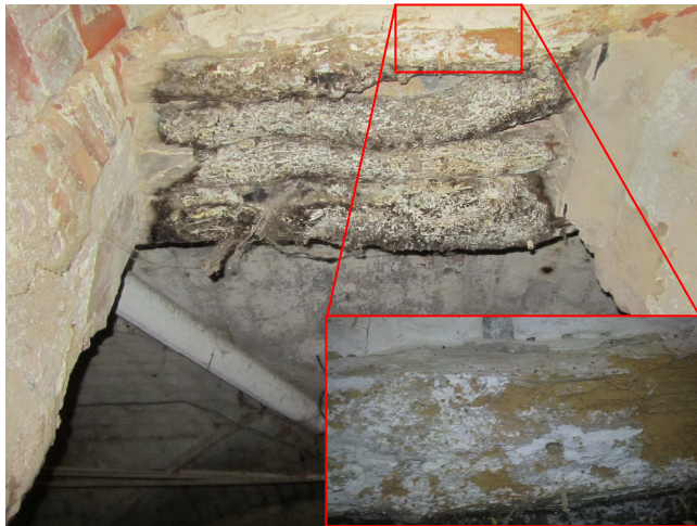
Foto 47: Fons de podrició blanca, en les bigues que fan de dintell, en la PB del primer volum.
