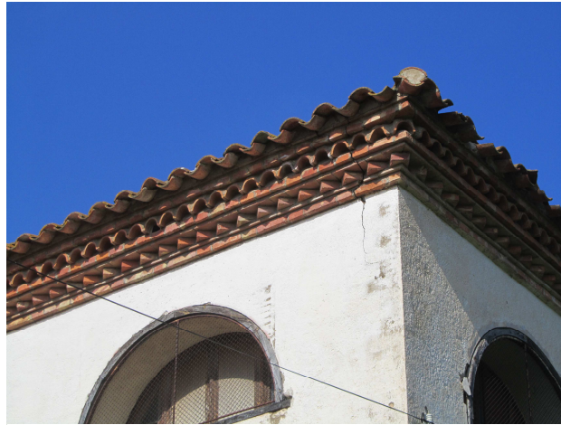
Foto 17: Esquerda obliqua en la cantonada sud-oest de l'edifici C.
