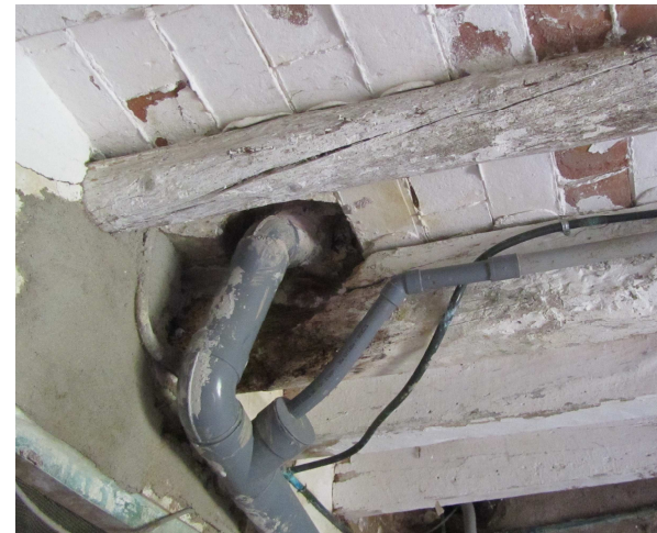
Foto 48: Podrició bruna i pèrdua de secció del cap de biga degut a la humitat accidental produïda pel pas del tub de PVC.
