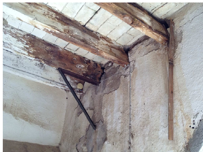
Foto 20: Podridió en els caps de les bigues causat per la presència d'humitats.
