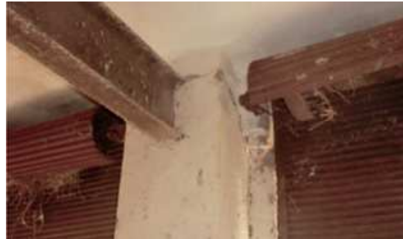
Foto 11: Esquerda obliqua provocada pels moviments del forjat metàl·lic. Font: Grup 1 DAC - Rehabilitació
