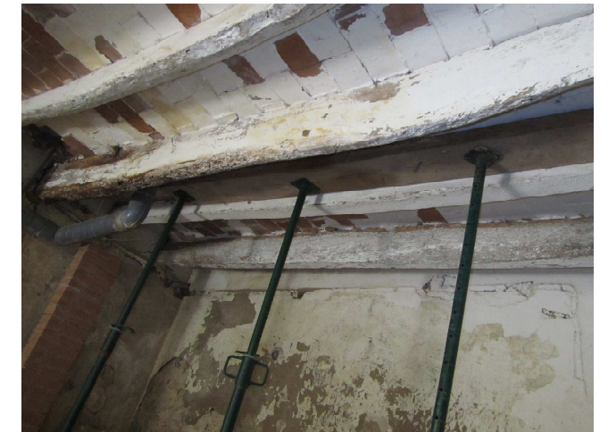
Foto 23: Reforç realitzat amb un tauló de fusta i puntals.
