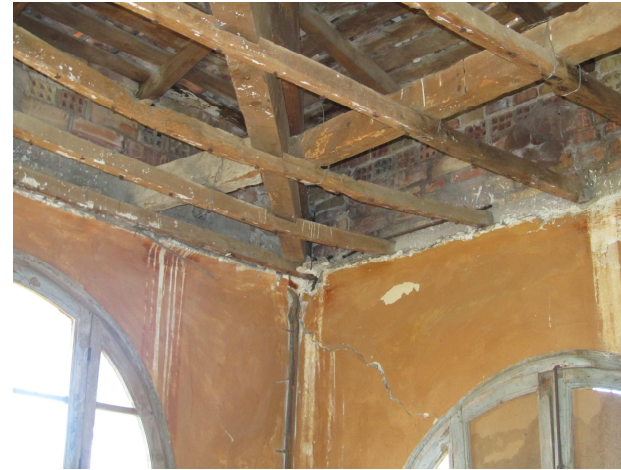
Foto 18: Vista interior de l'esquerda obliqua.
