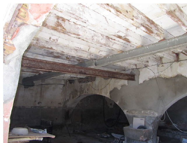
Foto 21: Trencallums per a contrarestar la pèrdua de capacitat portant del forjat.
