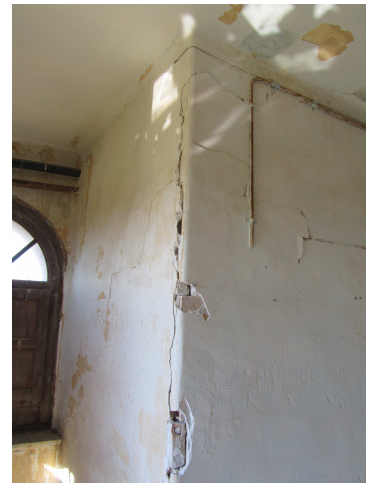
Foto 19: Esquerda vertical en la trobada entre dos envans.
