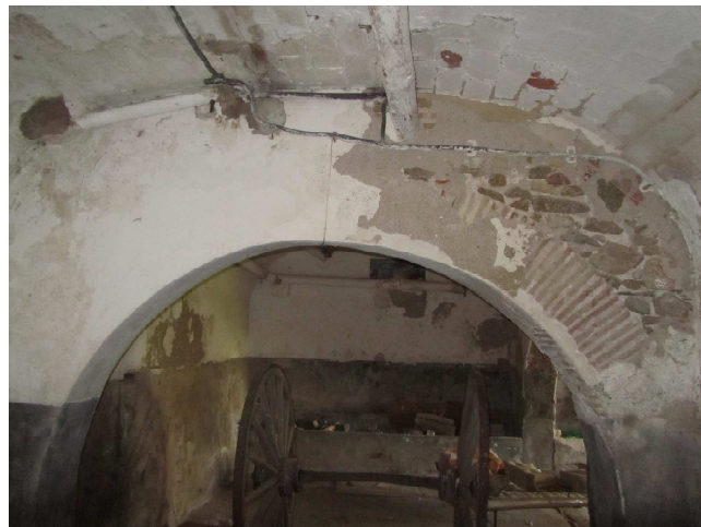
Foto 26: Voltes ceràmiques reforçades amb bigues de fusta embegudes en els arcs.
