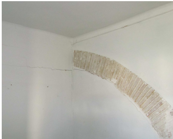
Foto 10: Esquerda horitzontal en la trobada entre l'arc i la divisòria interior.
