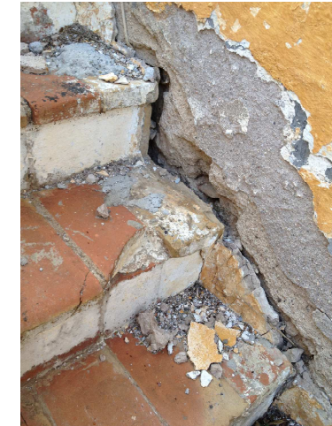
Foto 8: Esquerda obliqua en la trobada entre les escales i el mur.
