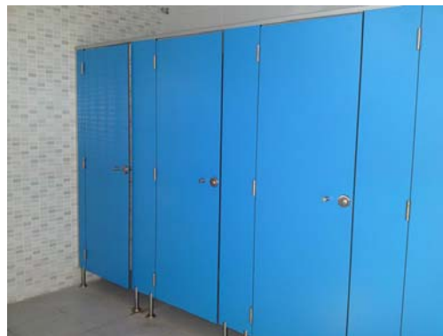
Figura 19. Ejemplo de puertas fenólicas con indicadores de ocupación y sistema de desbloqueo en caso de emergencia. 38
