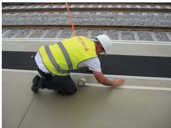
Figura 42. Ejemplo de colocación de baldosas adheridas. 52
