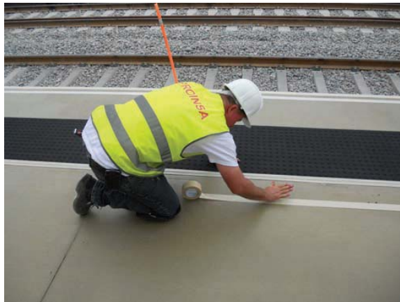
Figura 17. Ejemplo de colocación de baldosas adheridas. 35
