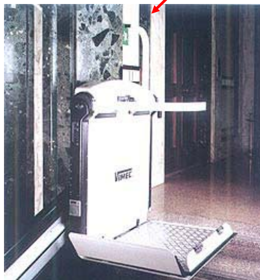
Figura 44. Croquis de colocación de plataforma montaescaleras.
