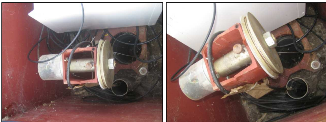
Figuras 20 y 21. Extensómetro de cable en Vallcebre. Se aprecia claramente el tambor, el sondeo en el que se introduce el cable, la cavidad para colocar el contrapeso, etcétera.
