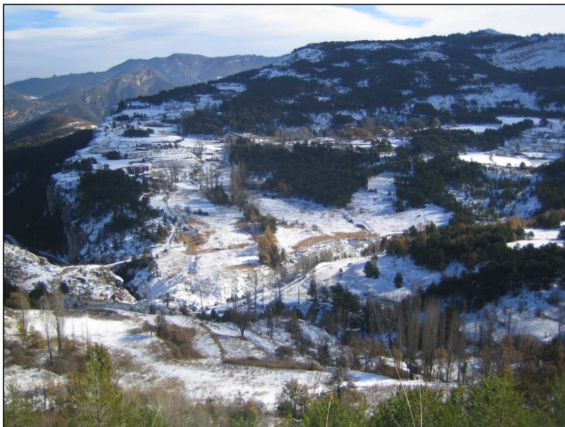
Figura 4. Fotografía de la ladera inestable de Vallcebre (Serrat de Sant Joan). En la parte inferior se intuye la existencia del torrente de Vallcebre, a la izquierda la barrera calcárea lateral y en la parte superior la cicatriz de la Serra de la Llacuna.
