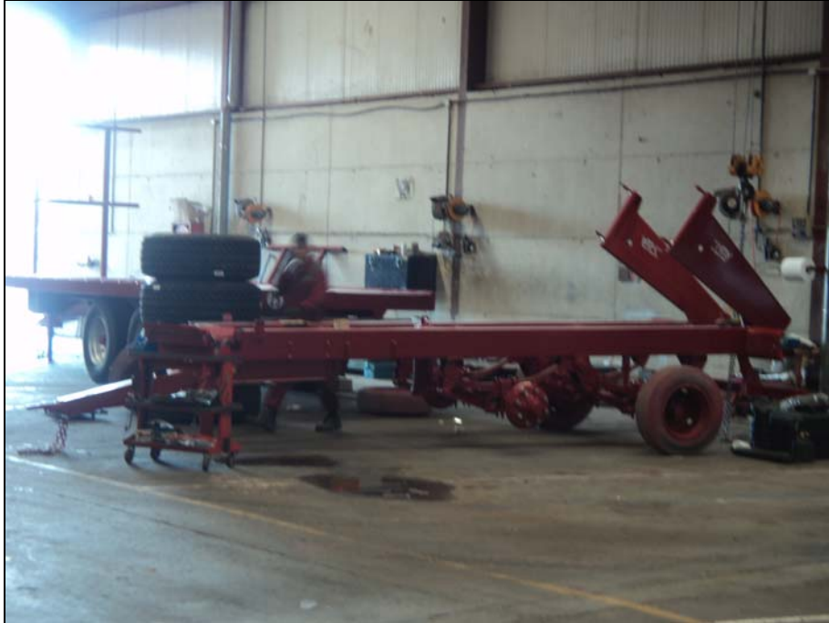
F.7.6. Zona montaje remolques
