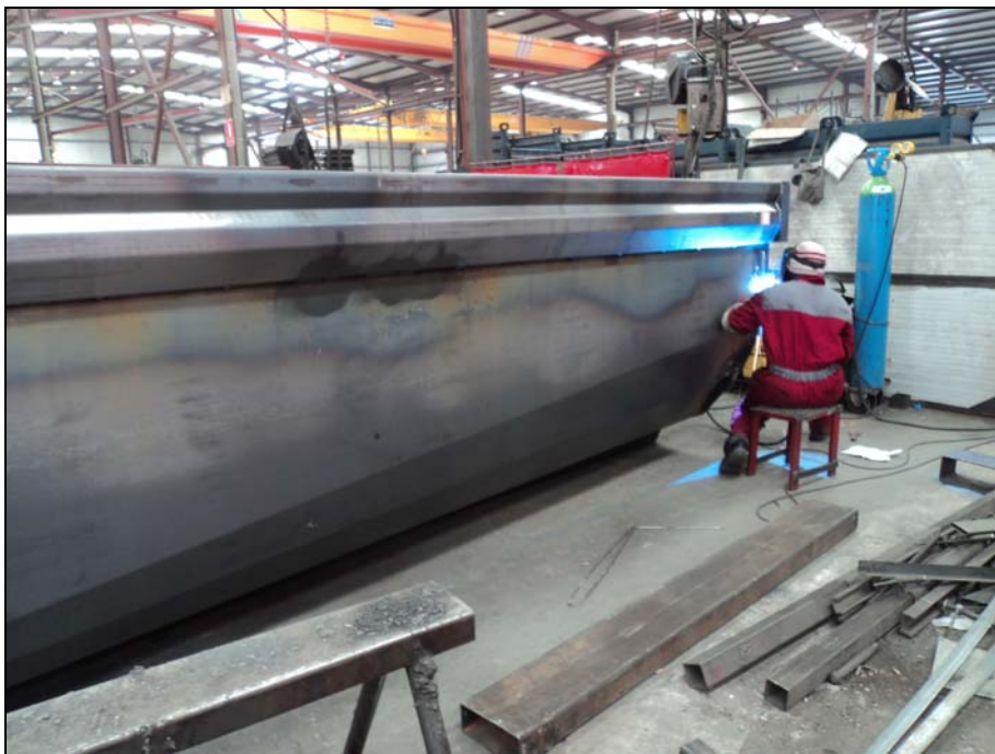
F.7.4. Zona soldadura bañeras
