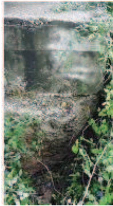
Fig. 46 - Erosió en una sabata
