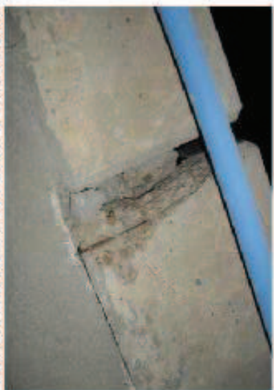
FOTO Nº 5: Solució de mossa amb armadura vista en el vial de dret.
