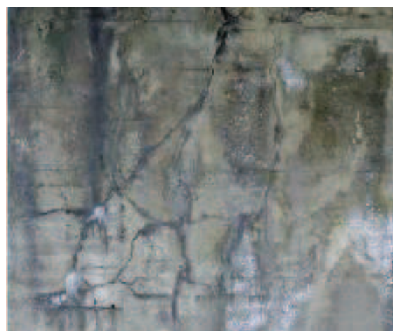
Fig. 40 - Efectes de retracció plàstica en un mur d'un estrep
