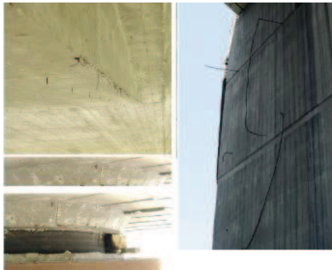
Fig. 44 - Exemples de claus i filferros al descobert
