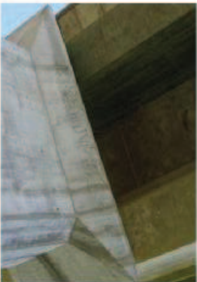
FOTO Nº 37: Dimecra de la fijuras longitudinales con espaldones cónicos, identico dato observado en otros dimecra.
