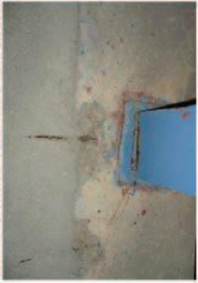
FOTO Nº 4: Arribada a una vista oberta després d'un pas i mossa de terra.
