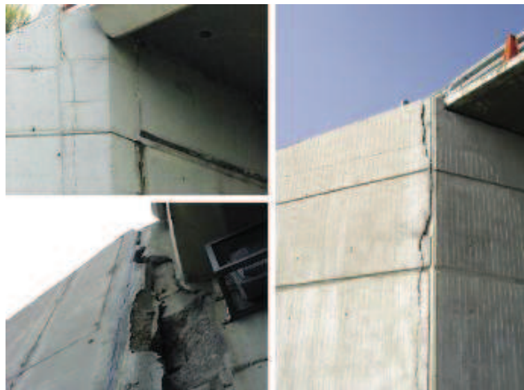
Fig. 31 - Exemples de separacions de paraments en l'aresta
