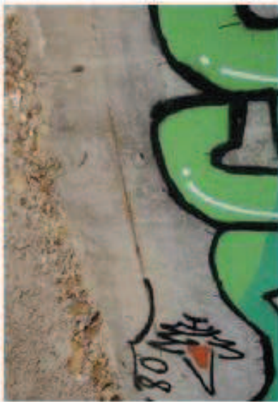
FOTO N° 28: Amadura vista por la base de la reparación en la base norte de la pile 10
