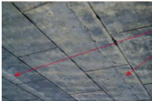
Fig. 12 - Fissures transversals en una llosa de cantell constant
