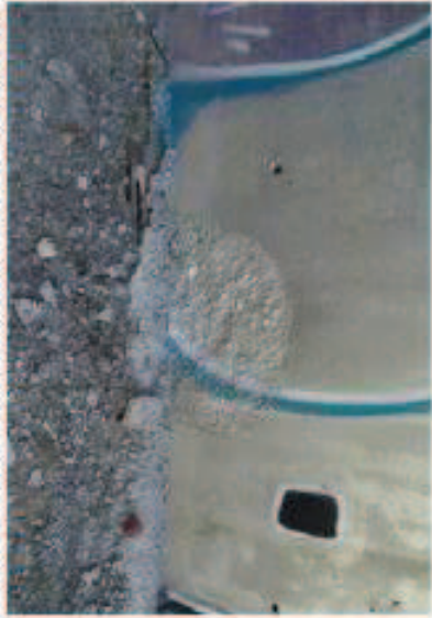
FOTO Nº 20: Descomposició en ambdues vores de la cara superior de la pla 4.
