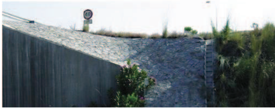
Fig. 3 - Protecció en talús per evitar l'arrossegament dels àrids
