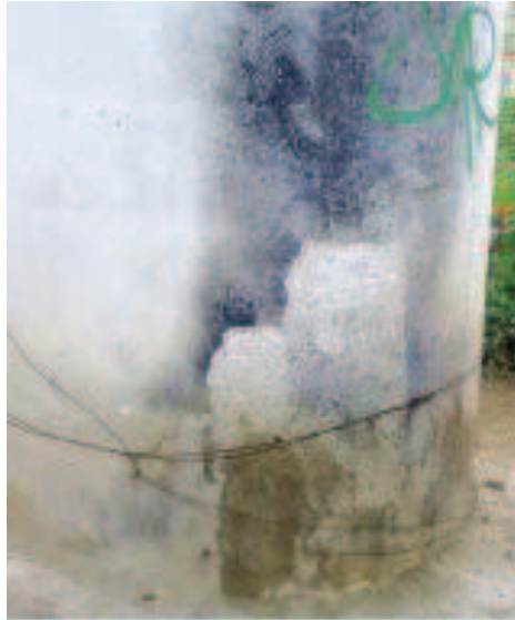
Fig. 49 - Acció del foc sobre un pilar i la consegüent pèrdua de recobriment
