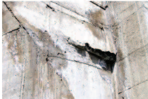
Fig. 33 - Moviment de l'encofrat
