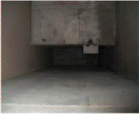
FOTO Nº 12: Vista desde la puerta del interior del estribo sur.
