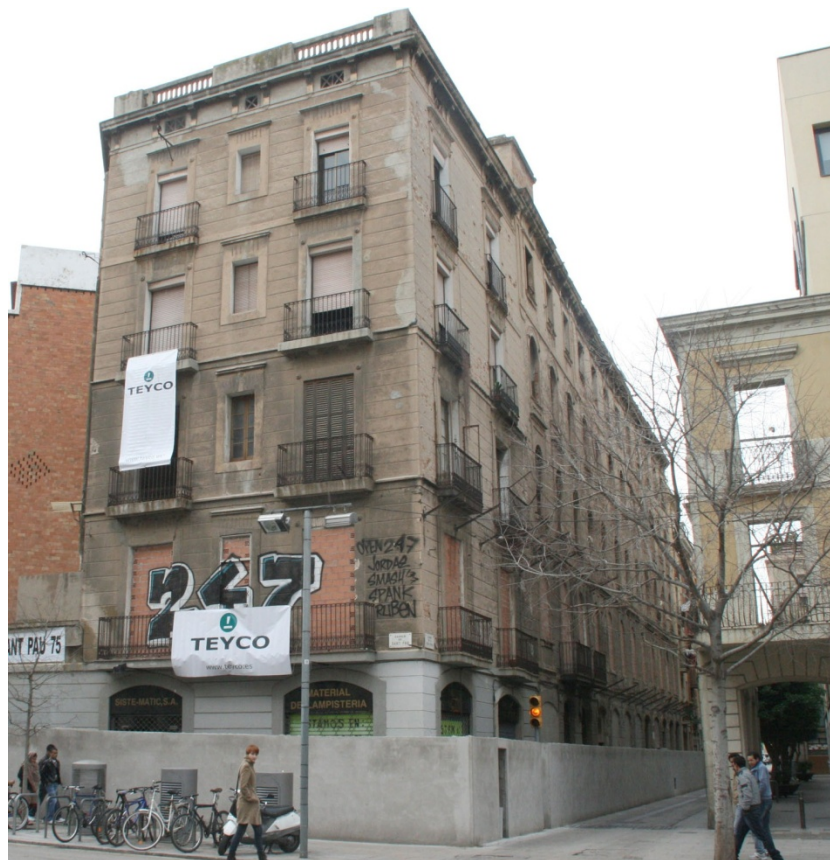
Il·lustració 2: Vista general del immoble
