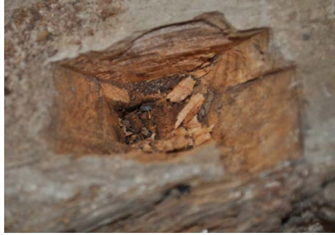
Il·lustració 22: Forat d'extracció d'un clau rovellat
