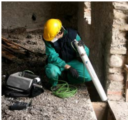
Il·lustració 33: Inspecció amb Resistògraf de caps de bigues
