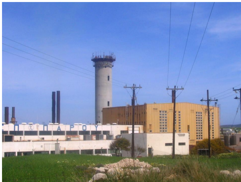
Fig.9 La fábrica de la Empresa Nacional de Electricidad que produce energía eléctrica a partir de combustión de mazut
