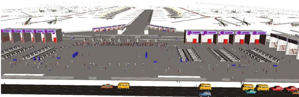
**Fig. 3.3.** La terminal vista desde el lado tierra. Se aprecia el vial de salidas, el vestíbulo de salidas, y, al fondo, el lado aire: la espada o dique longitudinal y varios aviones estacionados.
