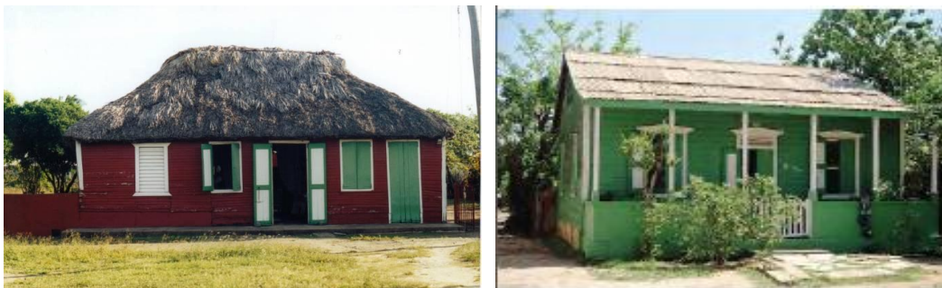
Fig.2- Ejemplo de viviendas con techos de palma y techos de zinc.
