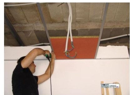
Fig.4- Colocación de un cielorraso o falso
