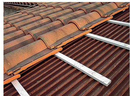
Fig.8- Tejas sobre chapas onduladas.
