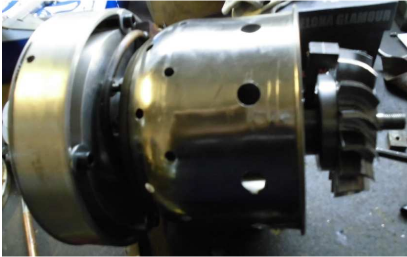
Fotografía 39. Montaje de la cámara de combustión, cuerpo de toberas y rigidizadores.
