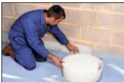
Figura 7.8. Col·locació banda perimetral [25]
