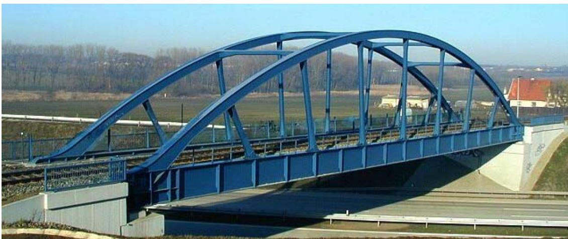
**Figura 1.1:** Puente formado por paneles rectangulares metálicos sobre la Prague Ring Road (Praga).
