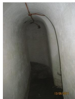
3.1. Passadís del soterrani del cos de l'edifici.
