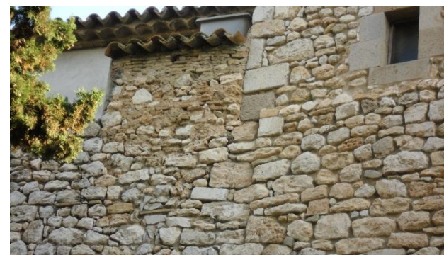
4.2. Detall de la junta de la muralla original amb la façana construïda posteriorment i l'Estudi Vidal.
