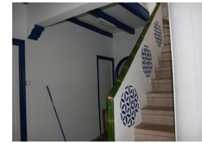
3.23. Escala que puja al terrat.
