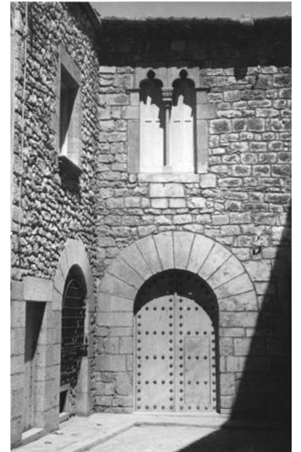
2.29. Fotografia de la façana del carrer d'En Bosc després de la rehabilitació de l'any 1947.
